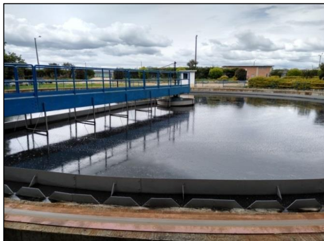
Imagen 17. Zanjón de Oxidación Sistema de Lodos Convencional
