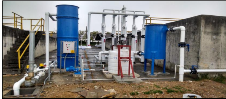
Imagen 18. Sistema de espesamiento de Lodo por Hidrociclón
