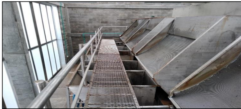
Imagen 11. Rejillas de cribado fino para partículas mayores a 3 mm y cajón de recolección de sólidos
