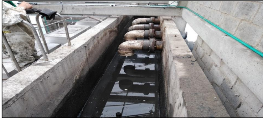
Imagen 10. Tanque de distribución Tamices Estáticos
