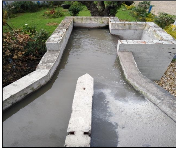
Imagen 12. División de caudal y vertedero de excesos desarenador
