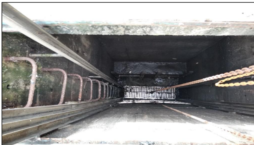
Imagen 5. Sistema de guías Canastilla de Cribado Grueso
