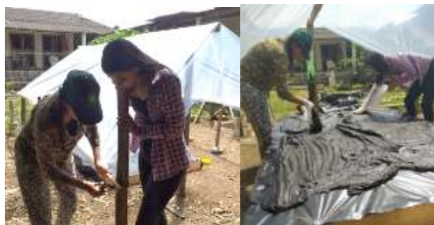
Figura 5. Construcción de la zona de deshidratación basado en un secador solar de invernadero y esparcimiento del lodo residual proveniente de una industria palmícola del Meta.
