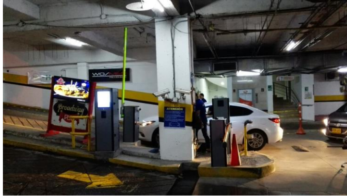
Imagen 5. Entrada vehicular al centro comercial, por Cristian González Guarnizo, 2017
