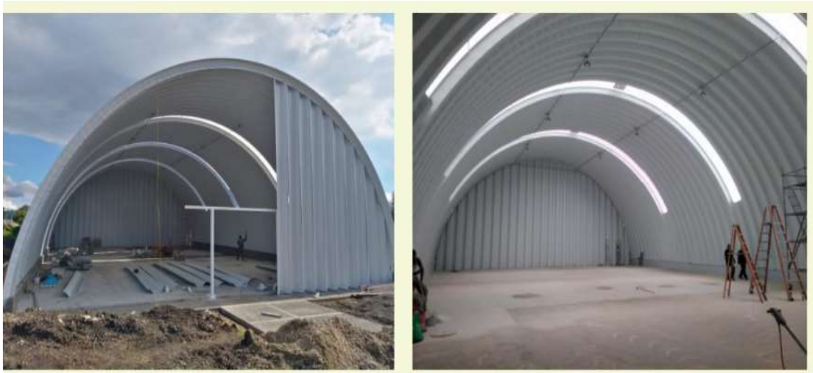
Figura 5. Infraestructura de la empresa
