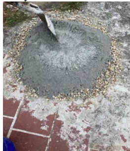
Figura 5. Disposición de los agregados y cemento.
