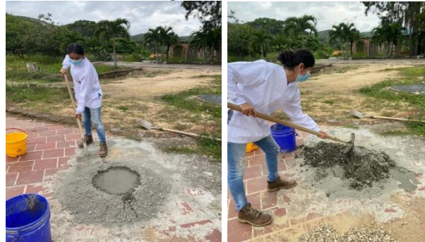
Figura 6. Proceso de mezclado del hormigón en laboratorio
