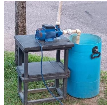
Figura 17 Bomba para el sistema de recolección
