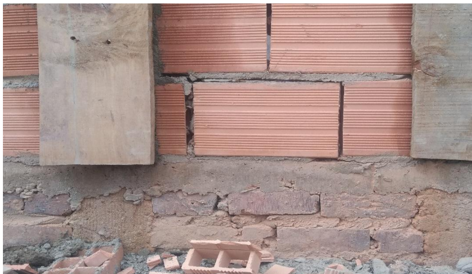
Figura 3. Registro fotográfico de muro.
