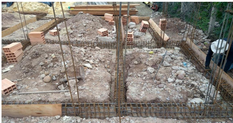
Figura 4. Registro fotográfico de estructura.
