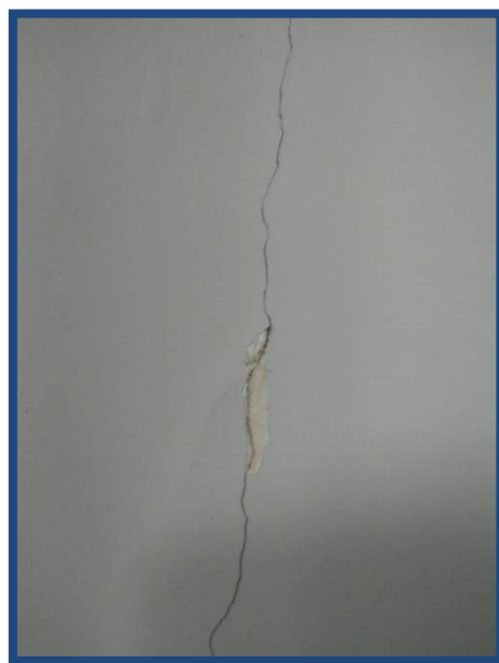
Figura C9-13. Lesión: fisura en columna. Fuente: Figura C9-13a. Lesión: fisura en columna. Fuente: Autores.
