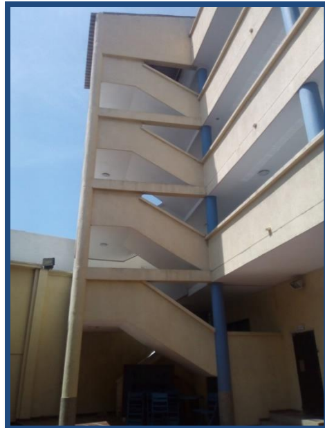
Figura C12-9a. Fachada interior edificio #2. Fuente: Propia
