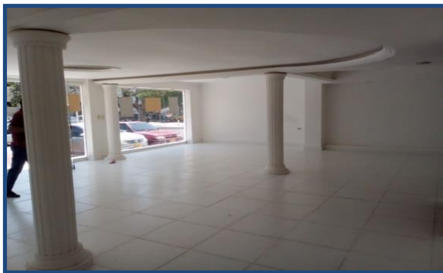
Figura C12-13. Muros internos tipo 1 edificio #1. Fuente: Propia
