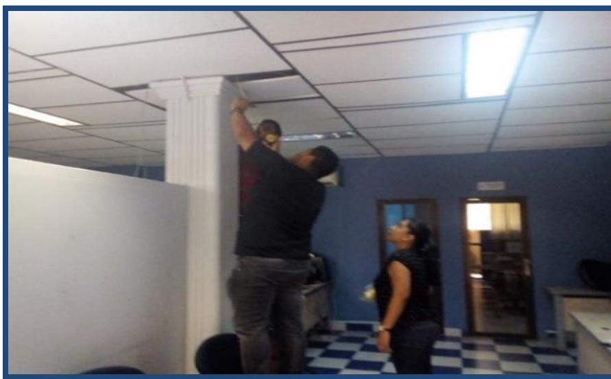
Figura C12-28. Cieloraso edificio #2. Fuente: Propia
