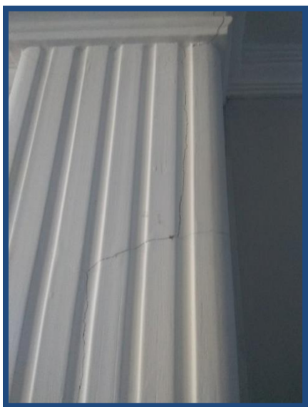
Figura C9-13. Lesión: fisura en columna. Fuente: Figura C9-13a. Lesión: fisura en columna. Fuente: Autores.
