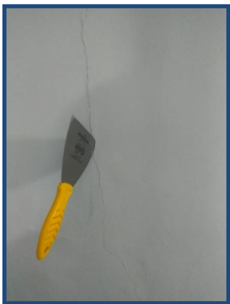
Figura C9-13. Lesión: fisura en columna. Fuente: Figura C9-13a. Lesión: fisura en columna. Fuente: Autores.
