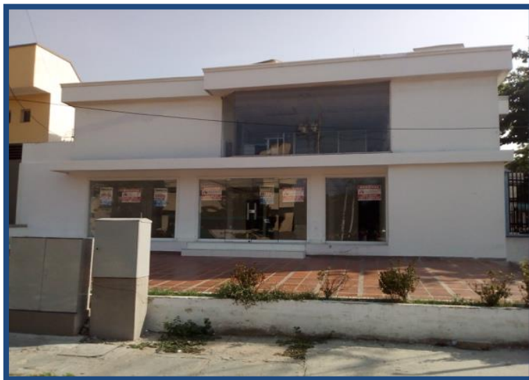
Figura C8-2. Fachada principal edificio #1. Fuente: Propia
