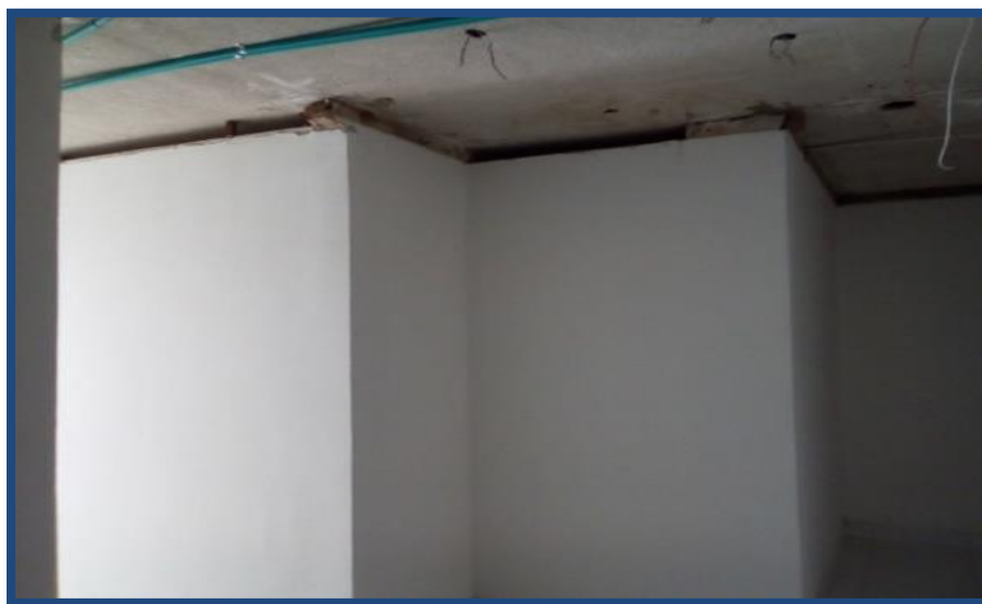
Figura C12-15. Muros internos tipo 2 edificio #1. Fuente: Propia
