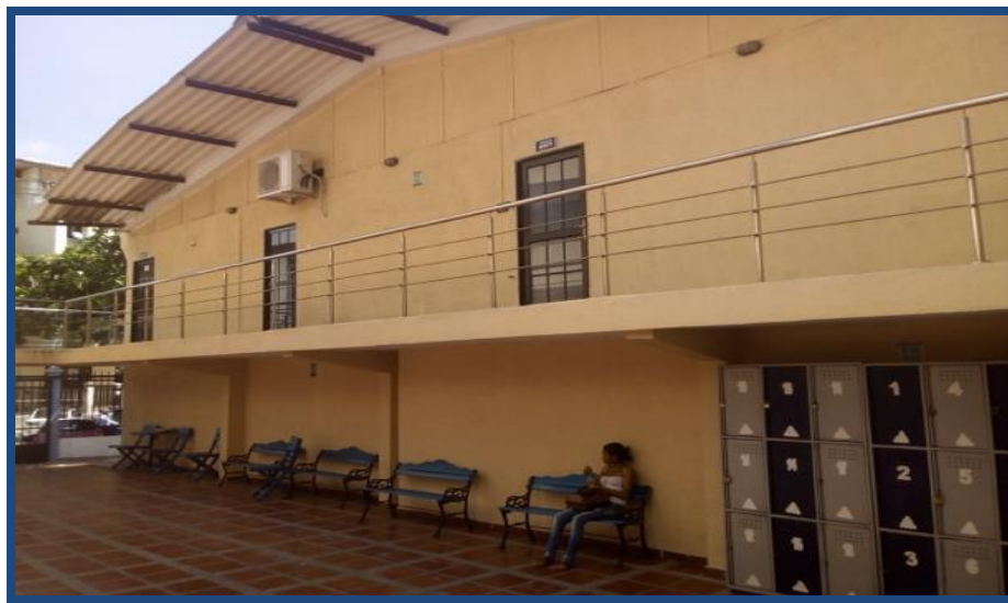
Figura C12-8. Fachada interior edificio #1. Fuente: Propia
