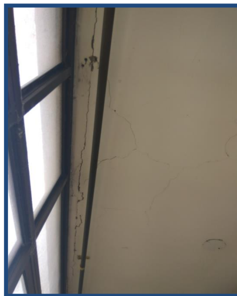
Figura C9-14. Lesión: fisura en losa. Fuente: Autores.
