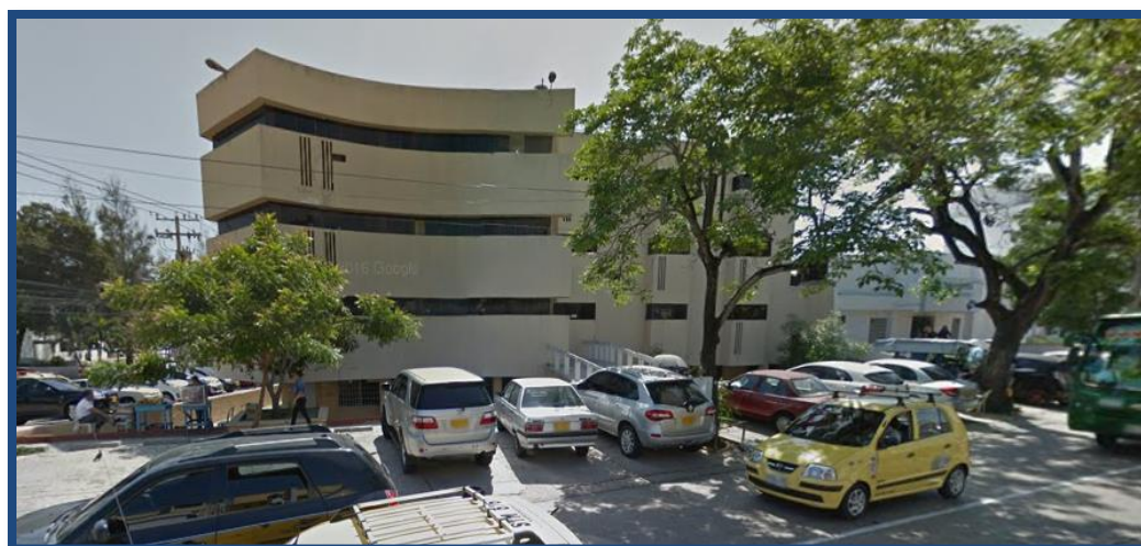
Figura C11-7. Edificaciones vecinas. Fuente: www.googlemaps.com
