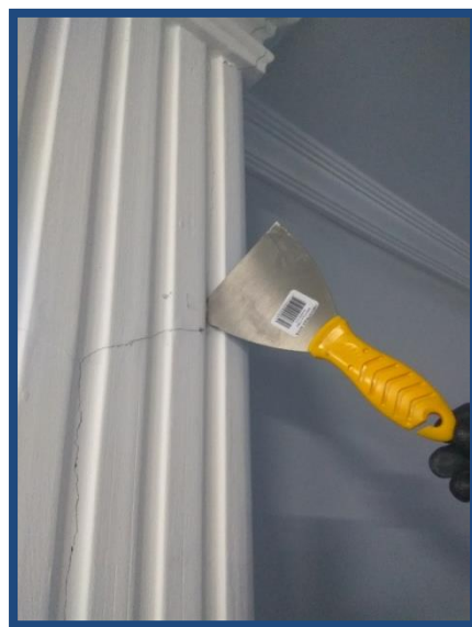
Figura C9-13. Lesión: fisura en columna. Fuente: Figura C9-13a. Lesión: fisura en columna. Fuente: Autores.
