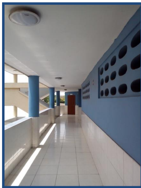
Figura C12-29a. Cielorastos edificio #2. Fuente: Propia
