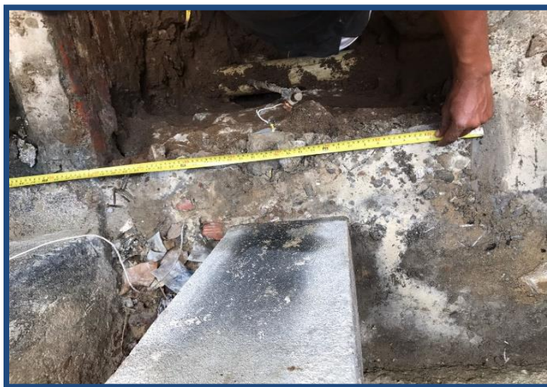
Figura C8-7. Dado de cimentación D3 edificio #1. Fuente: Propia
