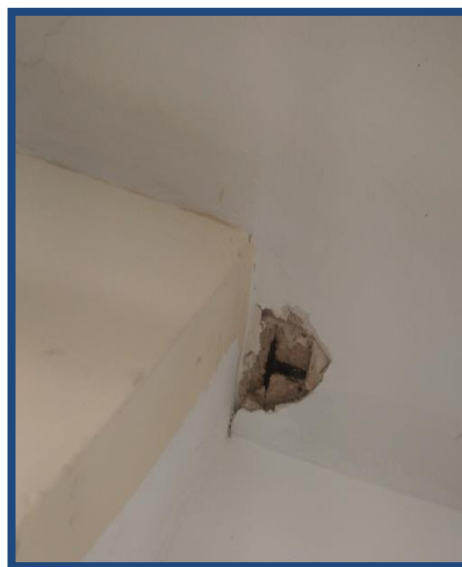
Figura C9-14d. Lesión: pérdida de recubrimiento. Fuente: Autores.
