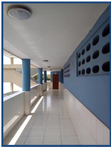
Figura C12-18. Muros internos tipo 5 edificio #2. Fuente: Propia
