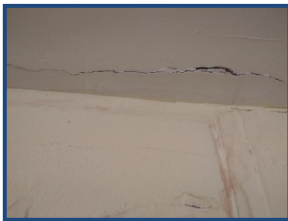
Figura C9-14. Lesión: fisura en losa. Fuente: Autores.
