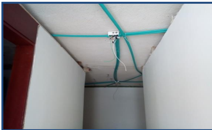
Figura C12-14. Muros internos tipo 2 edificio #1. Fuente: Propia
