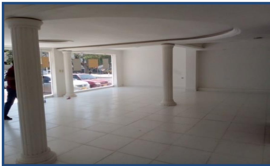
Figura C12-25. Cieloraso edificio #1. Fuente: Propia
