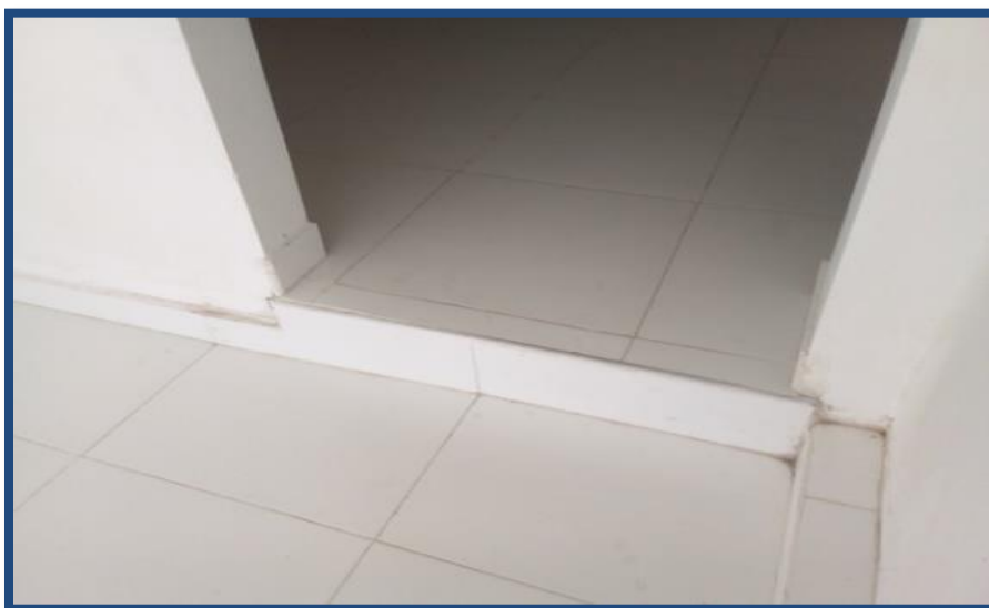
Figura C12-19a. Pisos 1° piso edificio #1. Fuente: Propia
