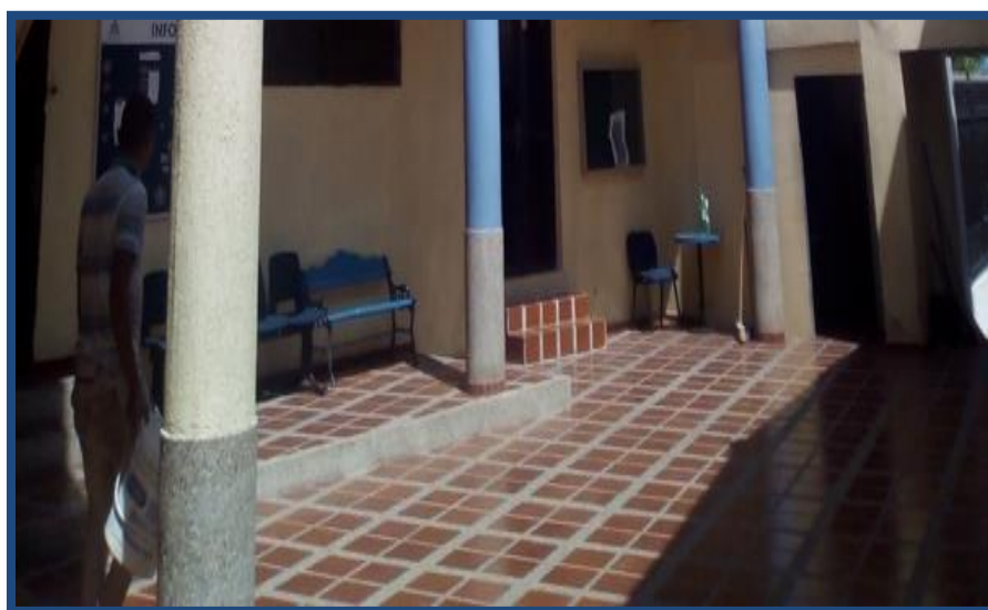
Figura C12-24. Pisos patio interior. Fuente: Propia
