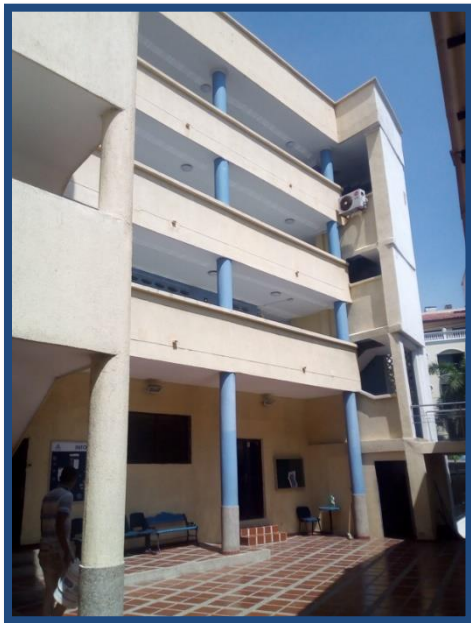
Figura C12-9. Fachada interior edificio #2. Fuente: Propia
