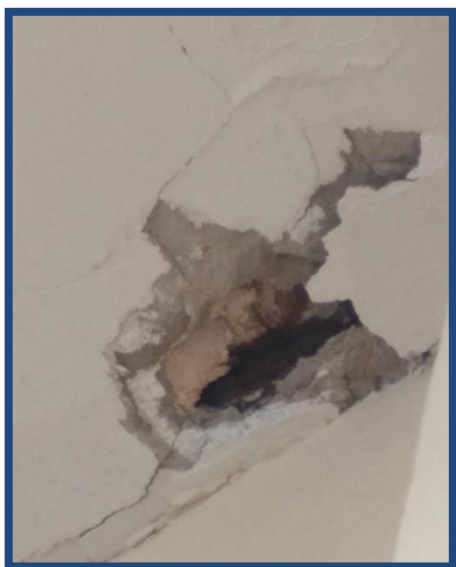
Figura C9-14c. Lesión: pérdida de recubrimiento. Fuente: Autores.
