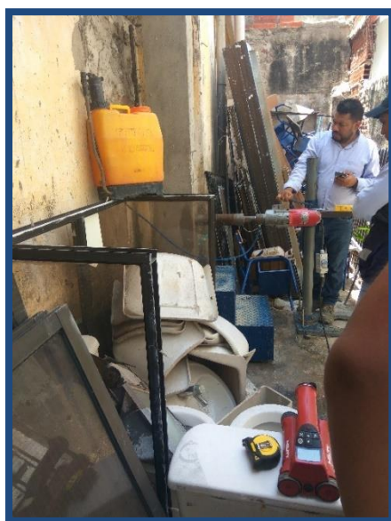
Figura C16-10. Extracción de núcleos columna D3 edificio #1 d. Fuente: Propia.
