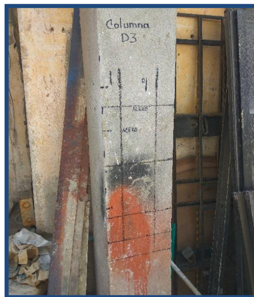
Figura C16-9. Marcación de aceros en la columna D3 Piso 1 edificio #1. Fuente: Propia
