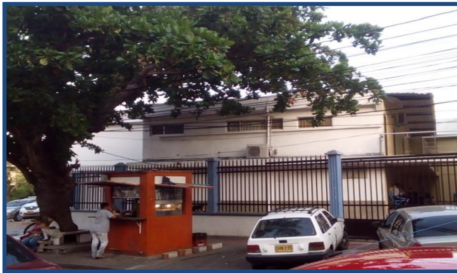
Figura C12-11. Fachada sobre calle 64 edificio #1. Fuente: Propia
