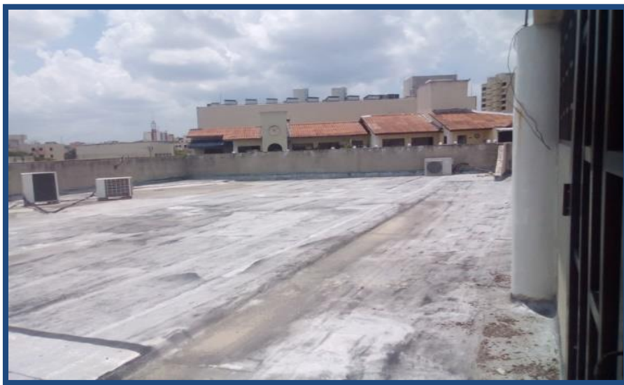
Figura C12-31. Cubierta edificio #2. Fuente: Propia
