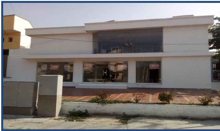
Figura C12-7. Fachada sobre carrera 53 edificio #1. Fuente: Propia
