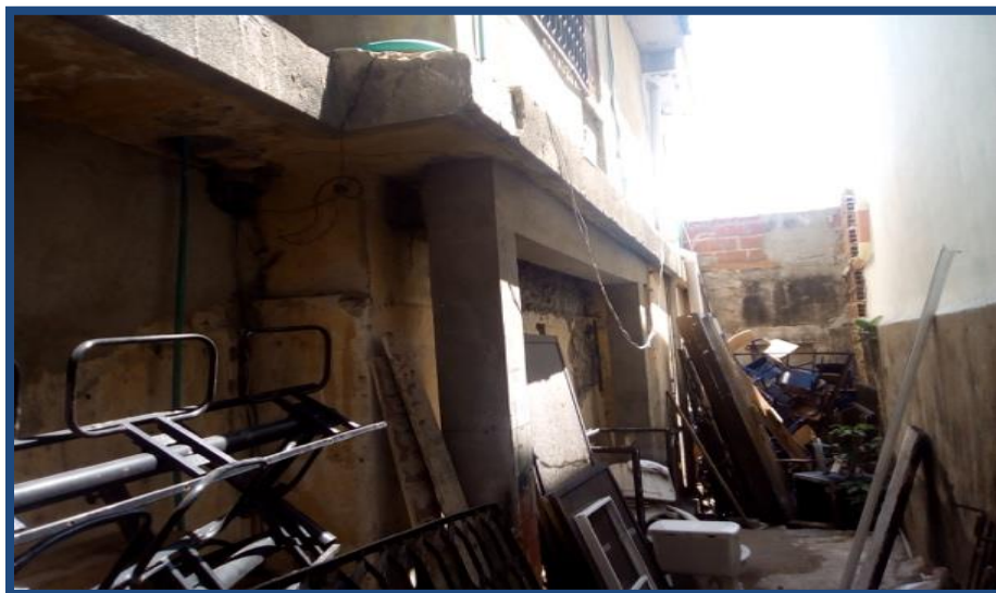
Figura C12-10. Fachada posterior edificio #1. Fuente: Propia
