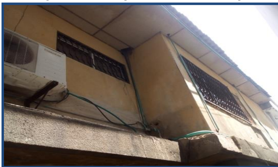
Figura C12-10a. Fachada posterior edificio #1. Fuente: Propia
