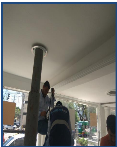
Figura C16-8. Proceso de instalación del ultrasonido en viga aérea piso 1 edificio #1. Fuente: Propia
