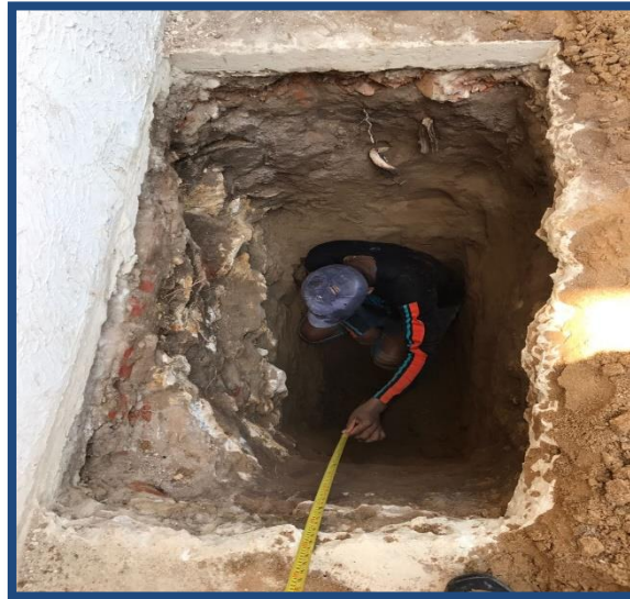
Figura C8-8. Excavación para reconocimiento de cimentación edificio #2. Fuente: Propia
