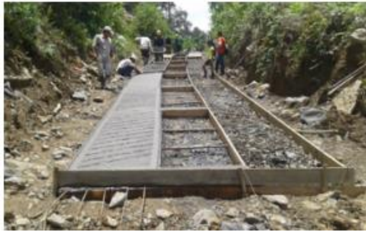
Figura 6. Placa huella durante la construcción Guacharacas, Bolívar
