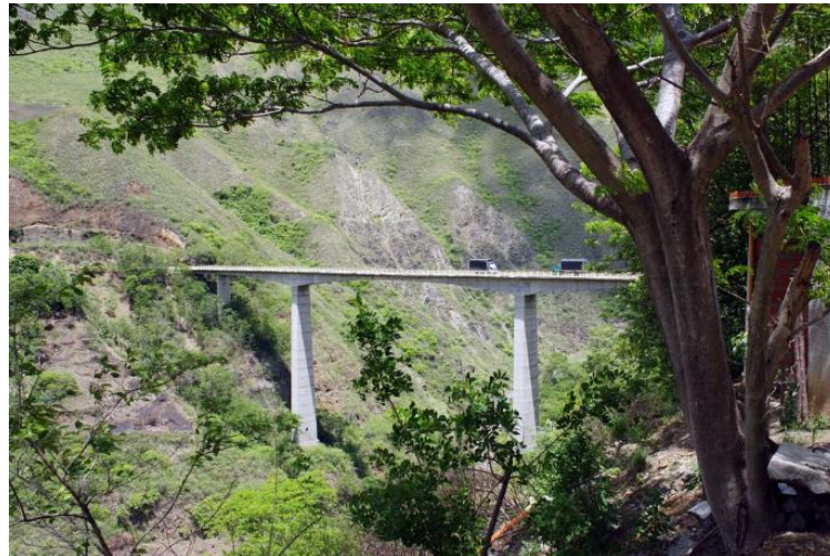
Figura 9. Puentes voladizos sucesivos sobre río Juanambú, Nariño.
