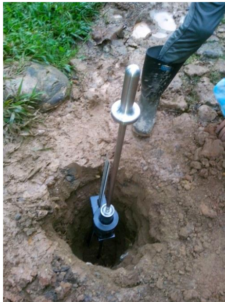
Figura 14 Ensayo penetrómetro realizado in situ
