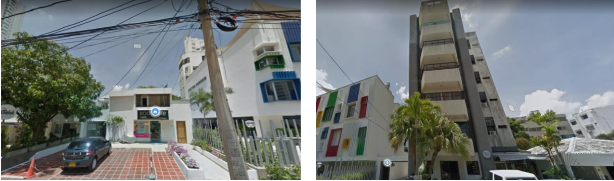
Figura 9. Vistas laterales del proyecto CBC, a mano derecha es la torre de apartamentos Isla fuerte, a mano izquierda es el local comercial Bodybrite Castillo Grande
