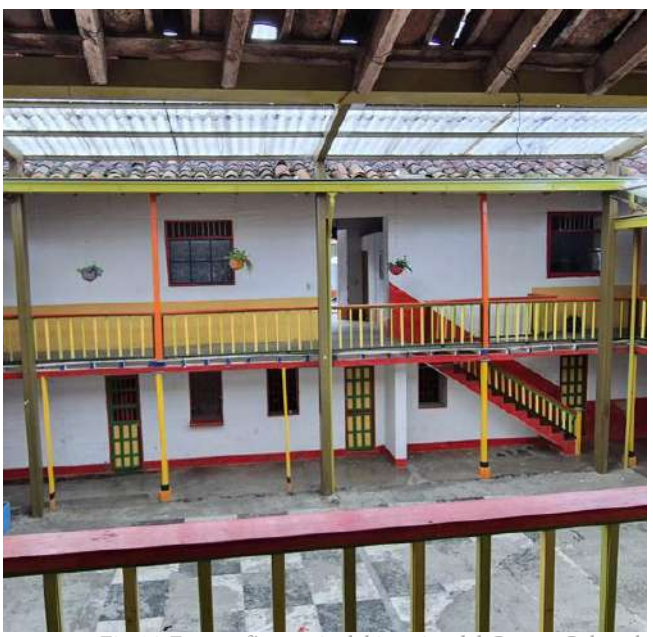
Fig.46. Fotografía propia del interior del Centro Cultural.
