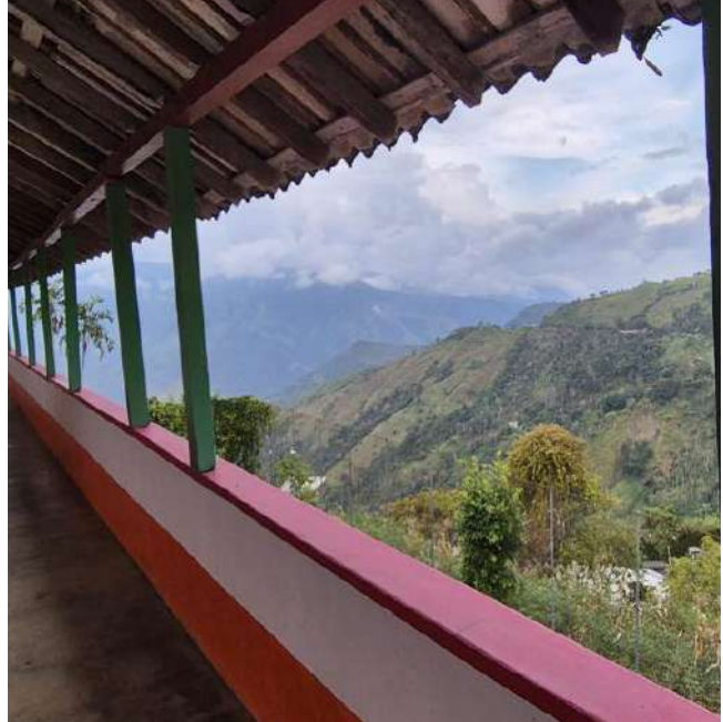
Fig.49. Fotografía propia de la fachada posterior.
