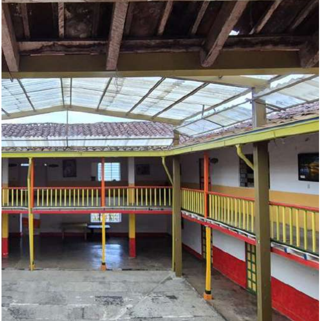
Fig.48. Fotografía propia del interior del Centro Cultural.
