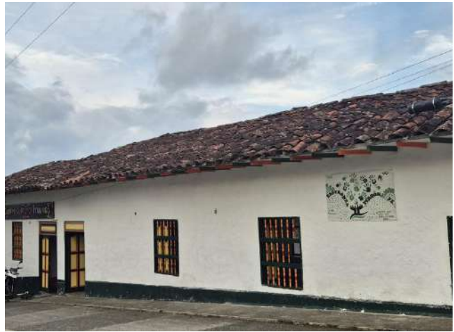
Fig.44. Fotografía propia de la fachada principal del Centro Cultural.
