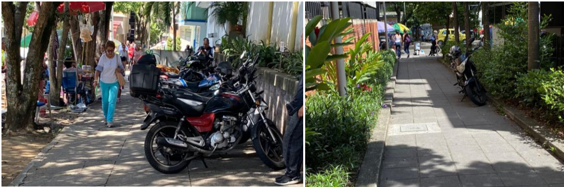
Figura 23. Obstáculos encontrados en el tramo 8 en las rutas de acceso a la clínica Bucaramanga.
