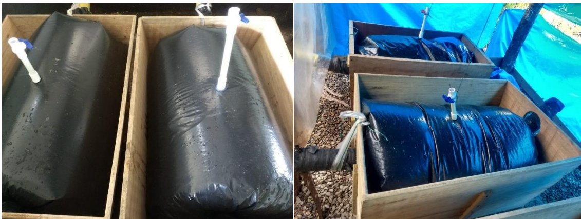
Figura 12. Biodigestor Institución educativa Guacavía. Por Gutiérrez & Ochoa, 2019.
