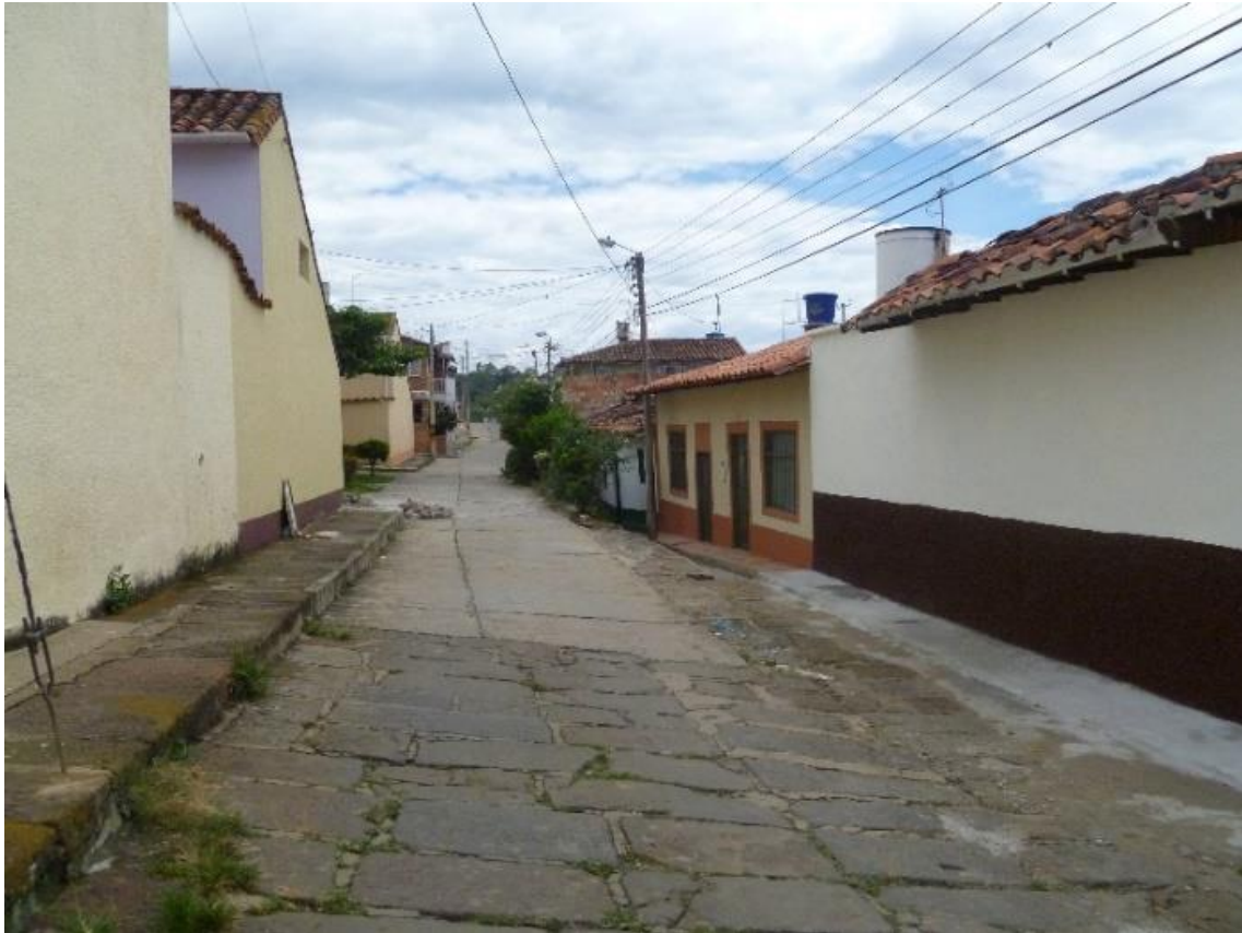
Figura 57. Imagen del sector de la calle 13, municipio de socorro - Santander.
