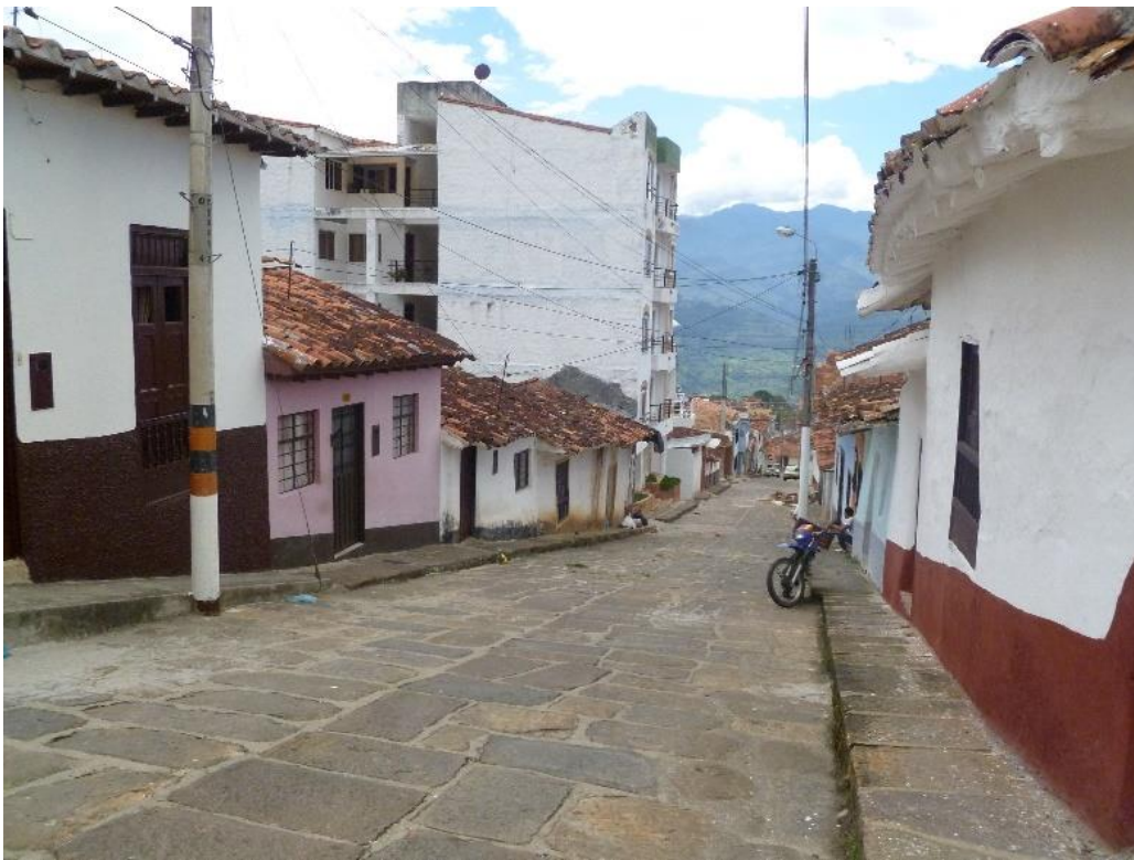
Figura 55. Imagen del sector de la calle 13, municipio de socorro - Santander.
