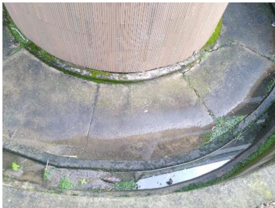
Figura 40. Parqueadero Edificio Santander
