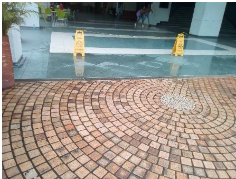
Figura 39. Entrada Edificio Santander
