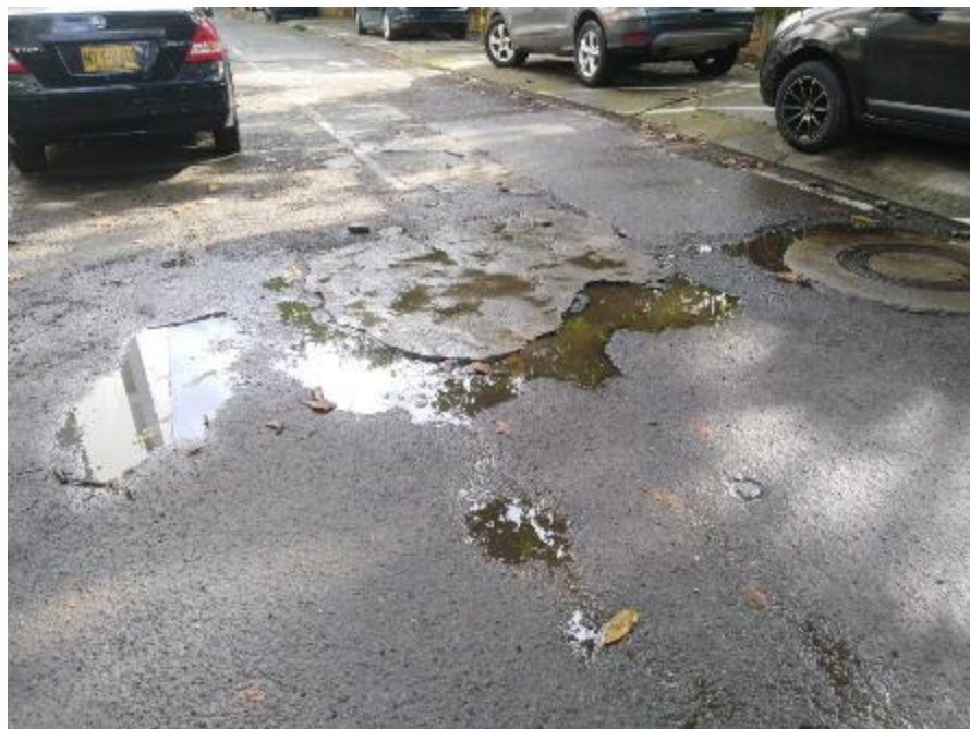
Figura 41. Parqueadero Edificio Santander
