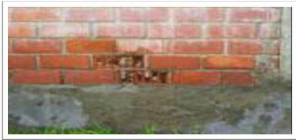
Ilustración 13. Humedad capilar
