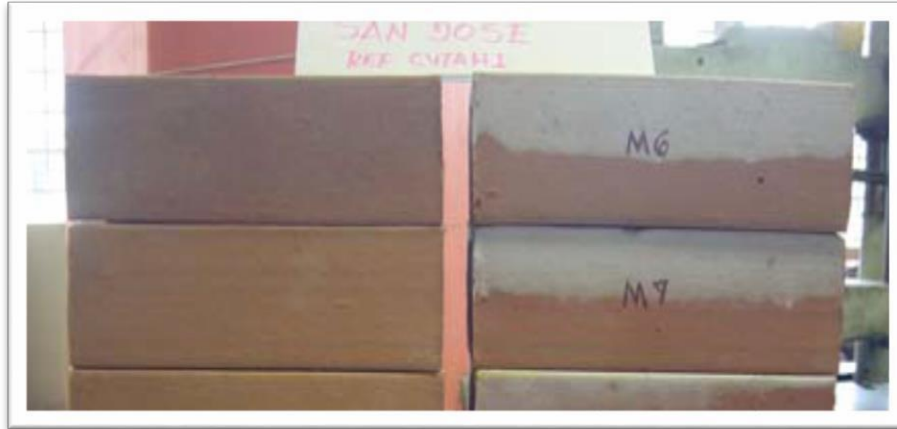
Ilustración 8. Revelado de sales eflorescibles
