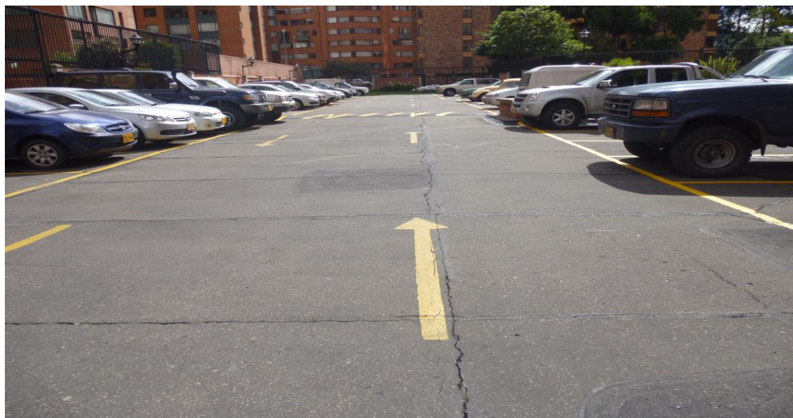
Foto 50 Plataforma vehicular ANTES de la intervencion. Fuente: construcción de los autores
