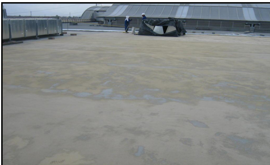
Foto 36. Aplicación de la tercera capa del SONOGUARD TOP COAT O SIMILAR, en un espesor de película húmeda de 20 mils. Fuente: construcción de los autores
