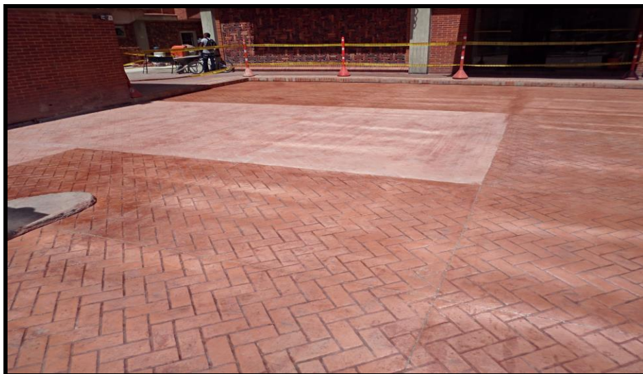
Foto 49. Aplicación de un sello para proteger el concreto estampado de los rayos uv y dar más durabilidad al sistema.
