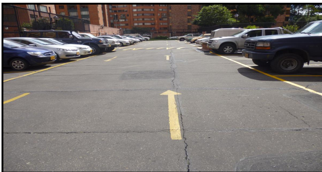
Foto 38. Plataforma vehicular ANTES de la intervención. Fuente: construcción de los autores
