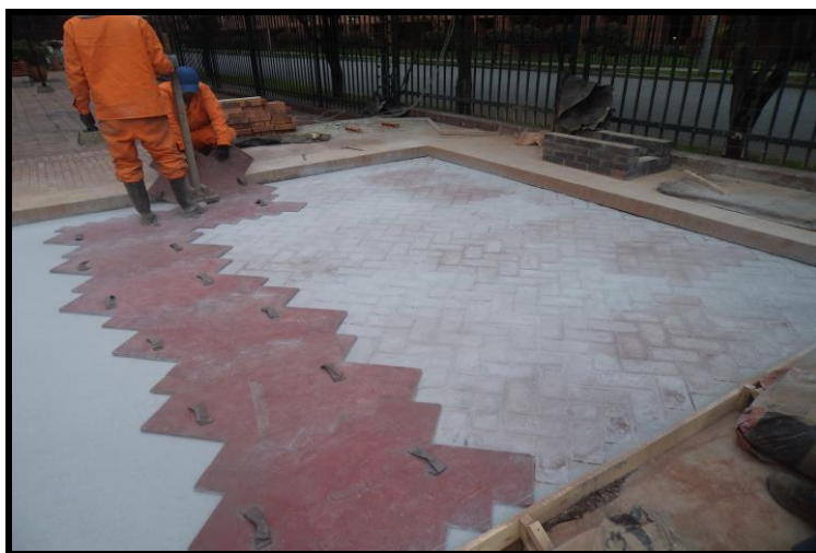
Foto 47. Estampillada del concreto con formaleta tipo adoquín en neopreno. Fuente: construcción de los autores
