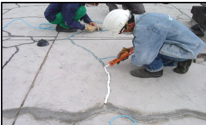
Foto 26. Sello de fisuras. Fuente: construcción autores
