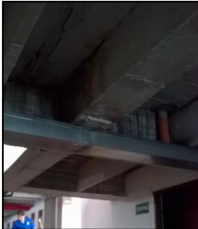
Foto 13. Fisuras observadas en la parte inferior de la losa. Fuente: construcción autores
