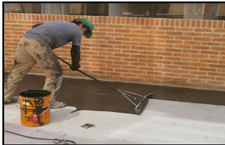
Foto 40. Se extiende con jalador. Fuente: construcción de los autores
