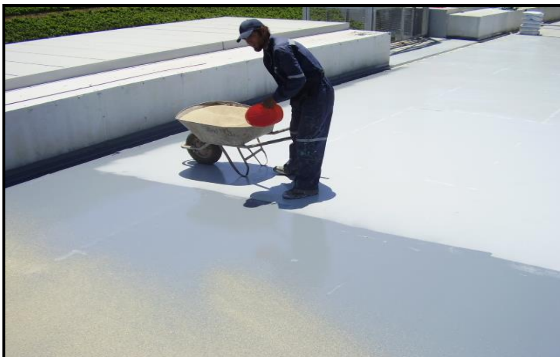
Foto 35. Espolvoreo una capa de Filler 5. Fuente: construcción de los autores
