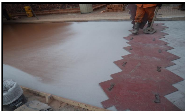
Foto 48. Se dan golpes con una tabla en madera con el fin de emparejar el estampado. Fuente: construcción de los autores
