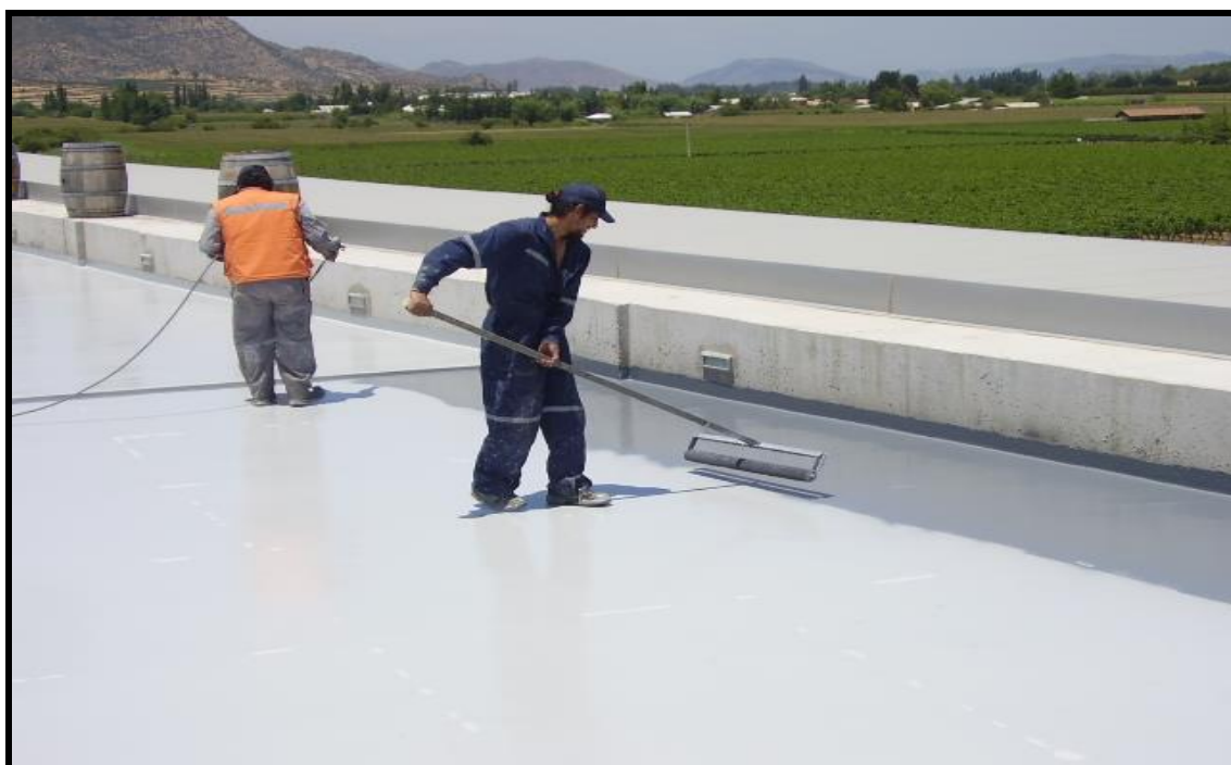
Foto 34. Aplicación de la Segunda capa del SONOGUARD TOP COAT MAS ARENA FILLER F-5 O SIMILAR, en un espesor de película húmeda de 20 mils. Fuente: construcción autores
