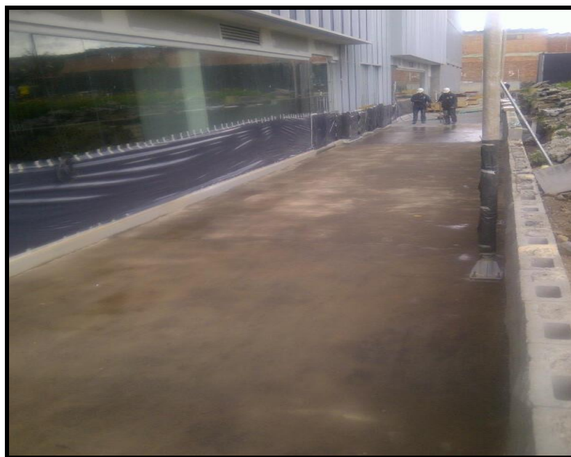
Foto 28. Aplicación de la primera capa del imprimante tipo mbrace primer mas arena filler f-3. Fuente: construcción autores
