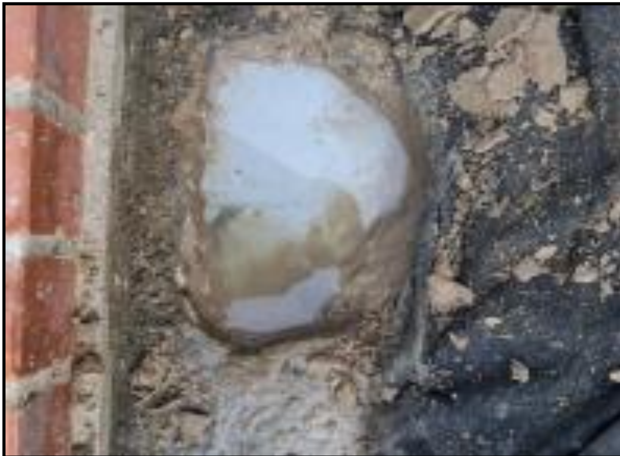
Foto 21. Apique 2. Fuente: construcción de los autores
