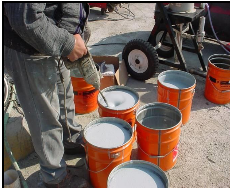
Foto 32. Procedimiento de aplicación. Fuente: construcción de los autores
