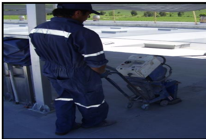
Foto 24. El sustrato debe tener perfil de anclaje tipo CSP 2 a 3 Fuente: construcción tores
