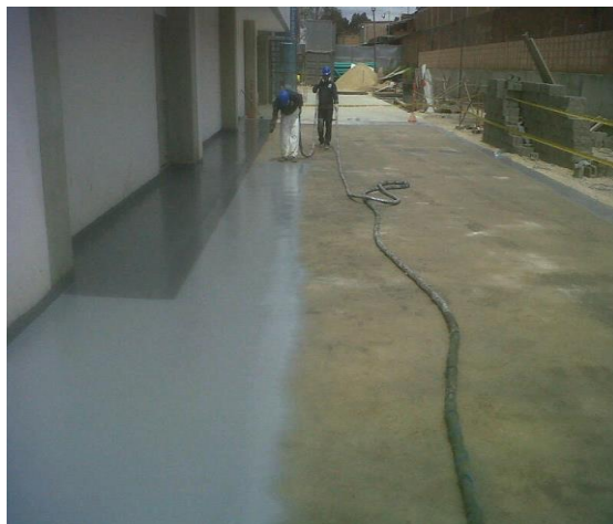
Foto 29. Aplicación de la POLIUREA TIPO ELASTOCOAT en un espesor de 80 mils con equipo mecánico tipo Graco.
