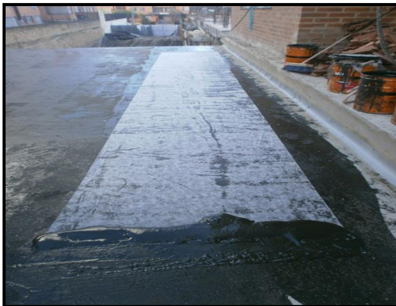
Foto 41. Instalación de la tela de poliéster con material de refuerzo. Fuente: construcción de los autores
