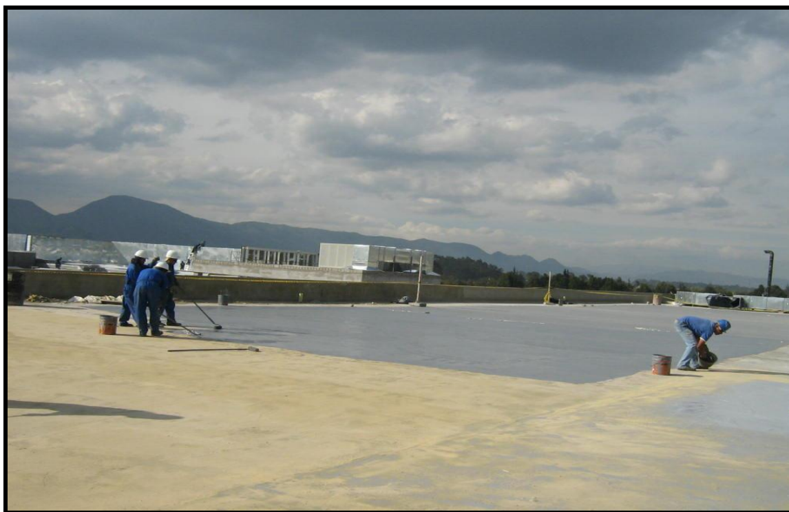
Foto 37. Sistema terminado. Fuente: construcción de los autores
