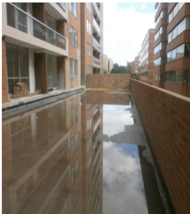
Foto 44. Prueba de estanqueidad por 48 a 72 horas. Fuente: construcción de los autores
