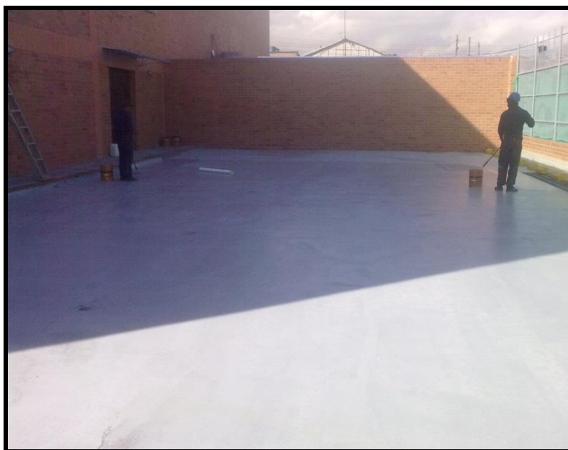
Foto 33. Aplicación de la primera capa del SONOGUARD BASE COAT, en un espesor de película húmeda de 25 mils.
