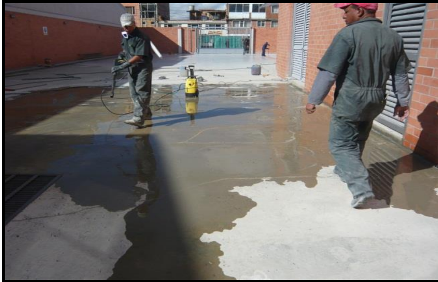
Foto 25. Limpieza del sustrato con equipo mecánico tipo hidro lavadora. Fuente: construcción autores
