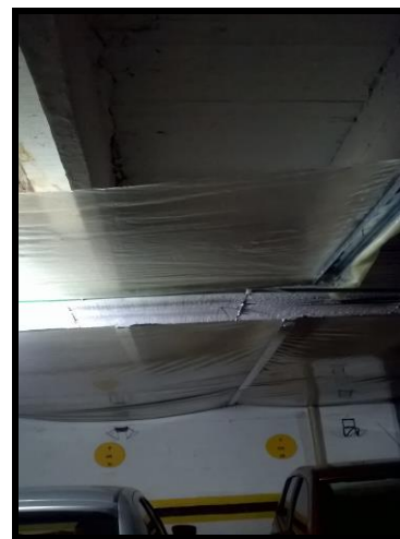
Foto 10. Dilataciones que no se realizaron en la losa estructural, y tampoco en la carpeta de asfalto que colocaron posterior. Fuente: construcción autores
