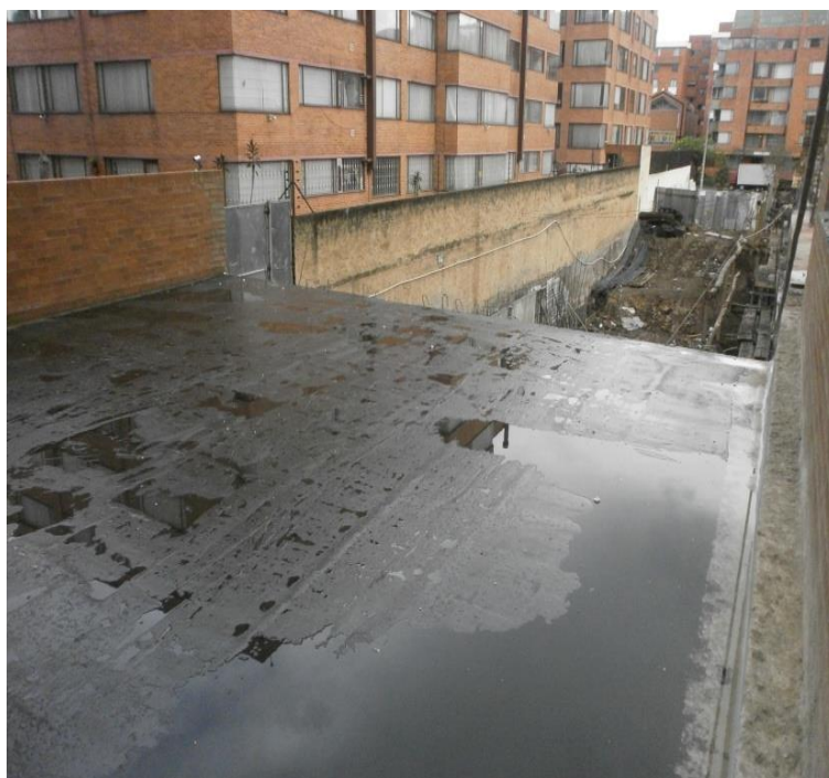
Foto 43. Sistema terminado con la tercera y última capa. Fuente: construcción de los autores
