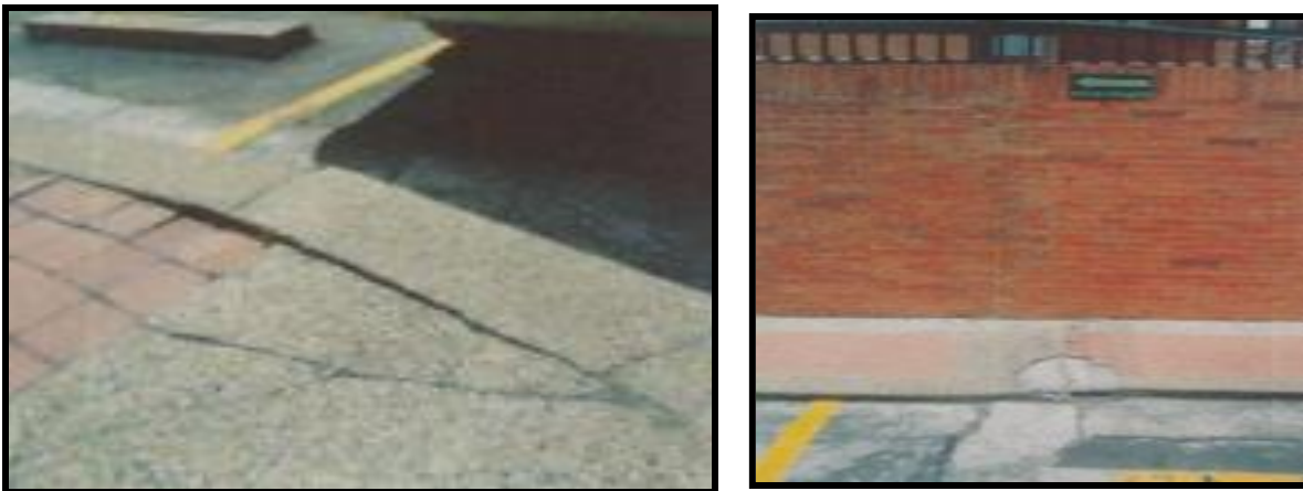
Foto 17. Las juntas de construcción. Fuente: construcción de los autores
