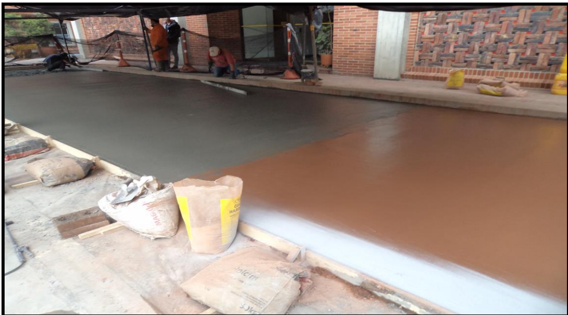
Foto 46. Extendida del concreto y espolvoreo del Endurecedor tipo cuarzo, color terracota.
