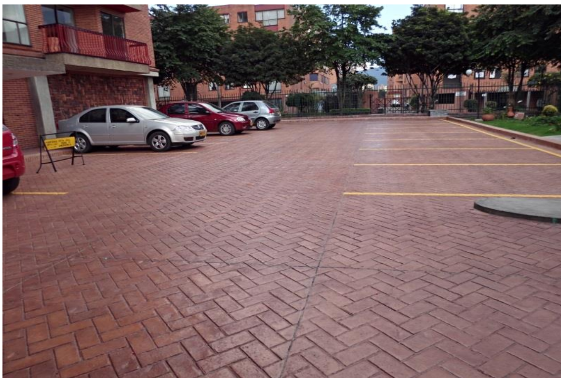
Foto 51. Plataforma vehicular DESPUÉS de la intervención. Fuente: construcción de los autores
