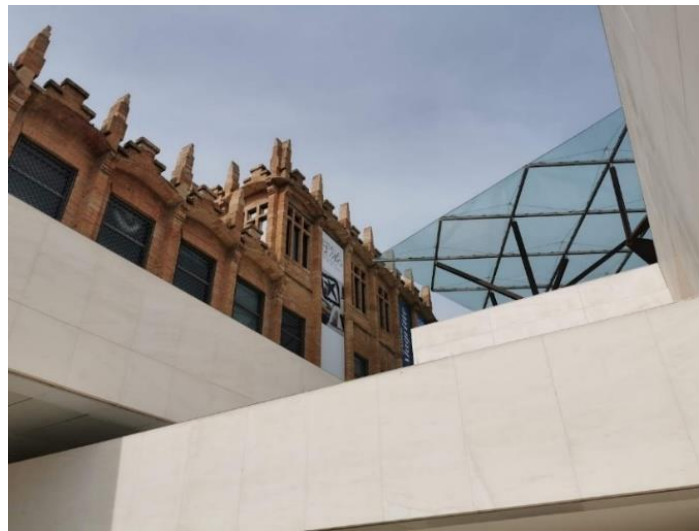
Figura 2. Centro cultural Caixaforum de Barcelona, intervención siguiendo la teoría del restauro crítico
