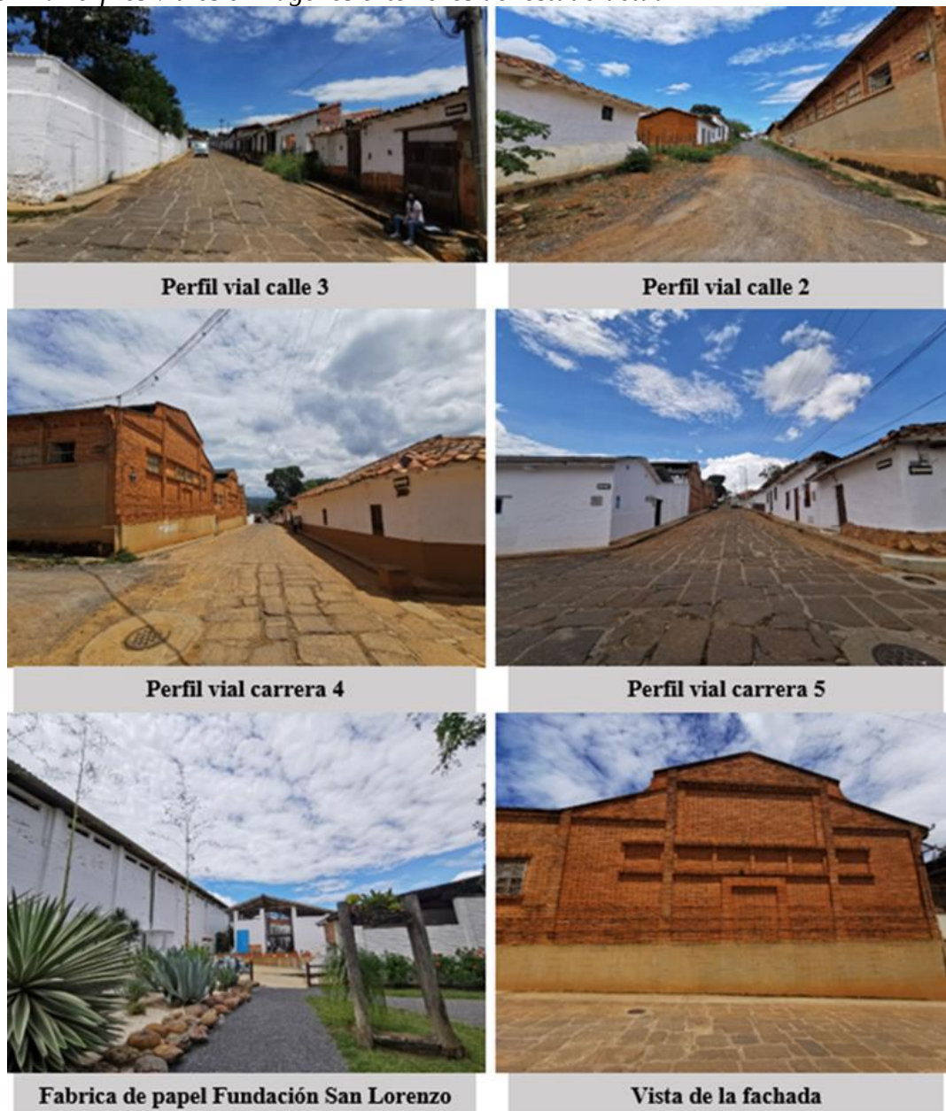
Figura 11. Perfiles viales e imágenes exteriores del estado actual
