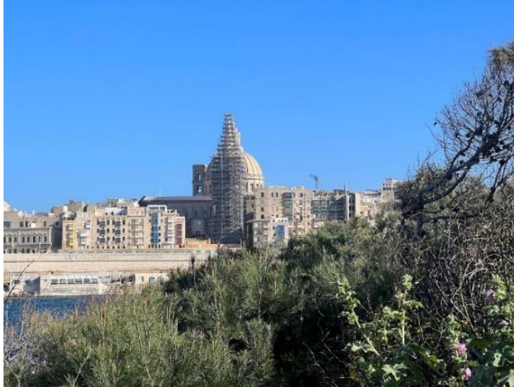
Figura 1. Restauración del campanario de la Procatedral de San Pablo en Il-Belt Valletta, Malta
