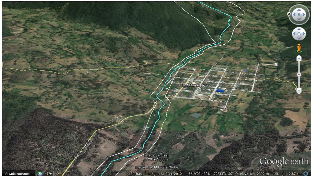
Imagen 16. Zonas que presenta vulnerabilidad en la parte media y baja de la Quebrada Negra.
