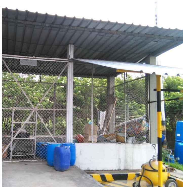
Figura 9. Cuarto de almacenamiento de residuos peligrosos
