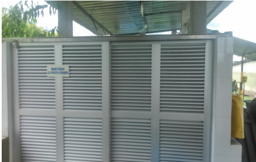
Figura 10. Cuarto de almacenamiento de residuos de riesgo biológico
