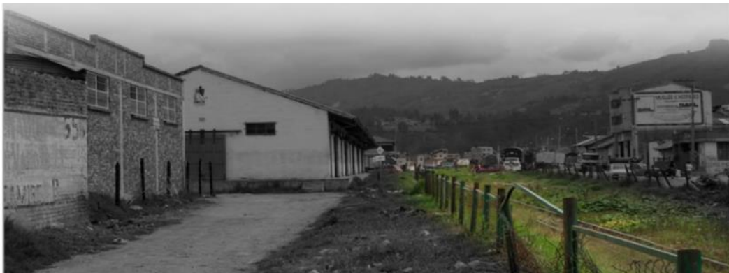
Ilustración 20 - Estado actual sector carrera 20
