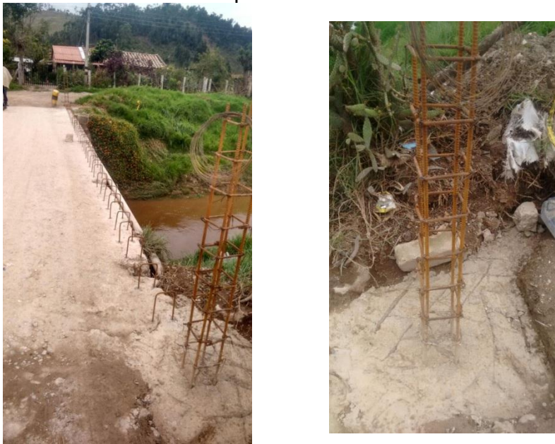
Ilustración 5: Parte del proceso constructivo de columnas y guardarruedas
