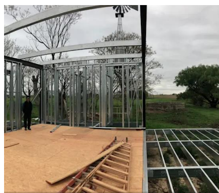
Figura 8. Armado de paneles
