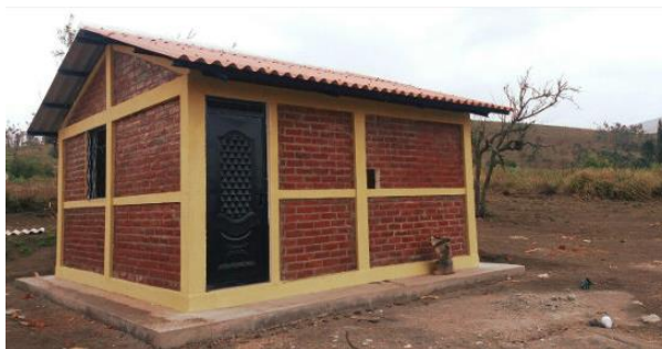
Figura 30. Casa en mampostería confinada
