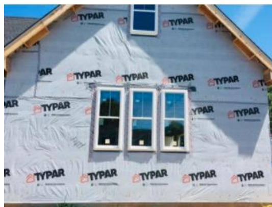
Figura 10. Instalación barrera de agua y viento (Typar)
