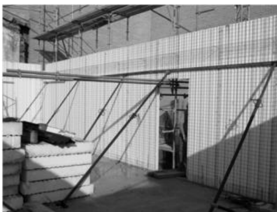
Figura 16. Aplomado de muros y apuntalamiento Durapanel
