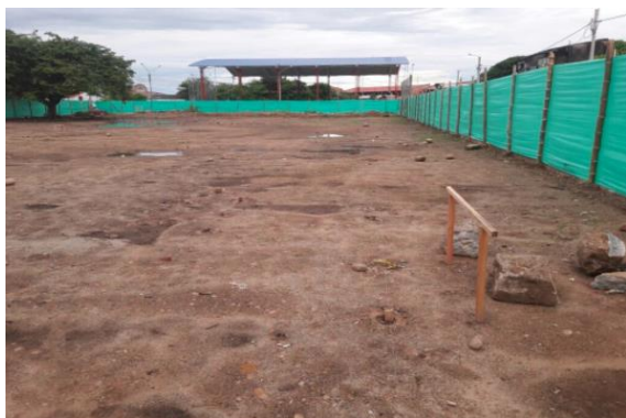
Figura 31. Localización y replanteo
