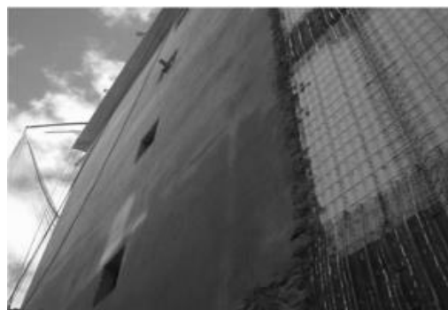
Figura 19. Afinado de los muros Durapanel
