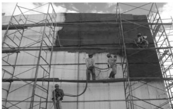
Figura 18. Lanzado de mortero Durapanel
