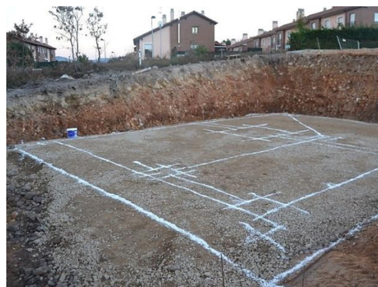
Figura 14. Etapa de replanteo Durapanel
