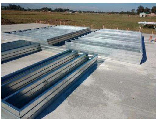
Figura 7. Perfilería Steel Frame
