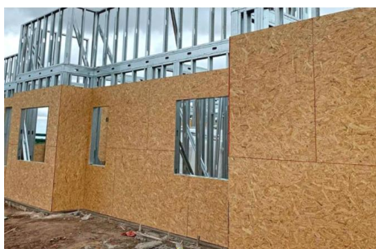
Figura 9. Instalación placas OSB
