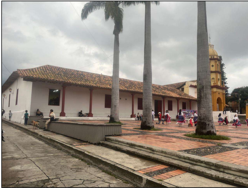
Figura 2. Estado Actual de Complejo Histórico La Gran Convención
