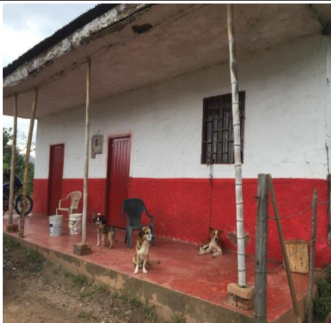
ZONA DE CORREDORES
