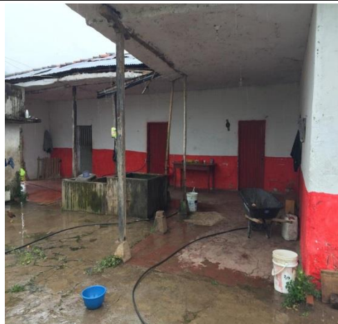
ZONA DE CORREDORES
