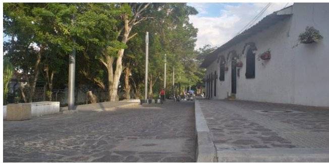
Figura 33 Fotografía calzada alameda las nieves
