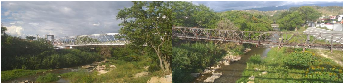
Figura 9. Fotografía ronda hídrica existente
