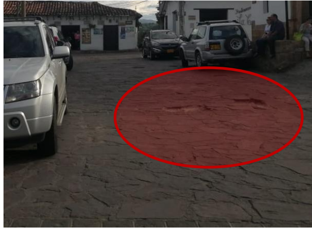
Figura 29 Evidencia de calzadas de piedra pegada desgastadas
