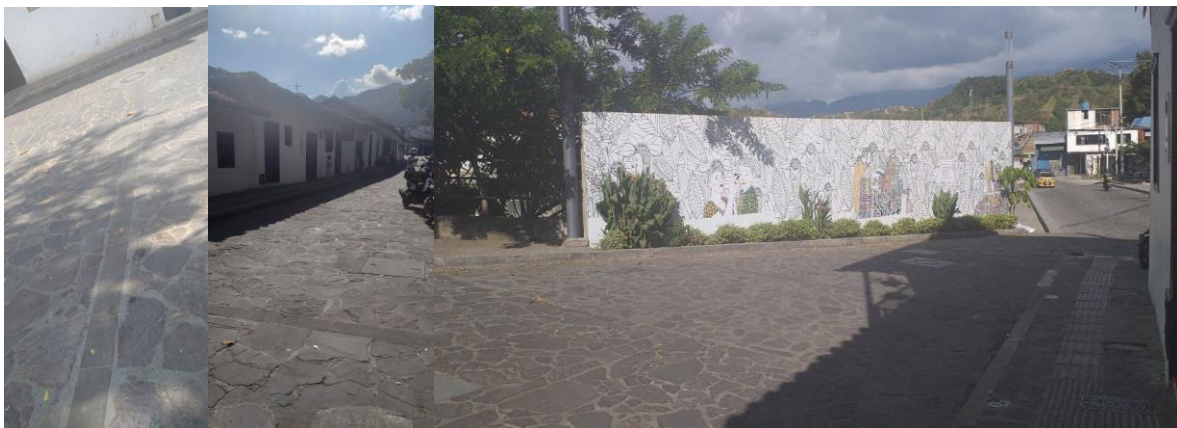
Figura 32 Calzada de la calle 27, zona de las fritangueras
