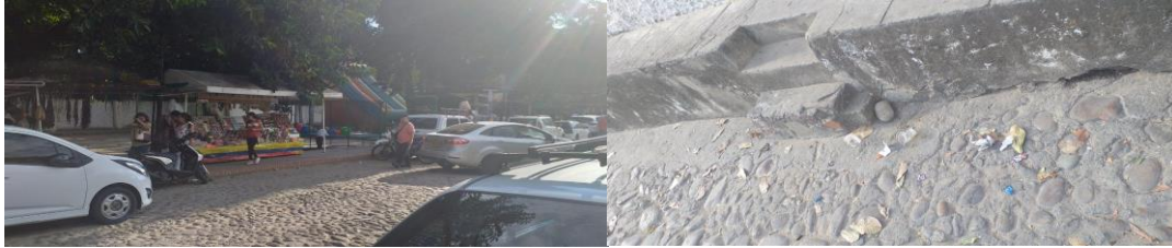
Figura 31 Calzada de la calle 27, zona de las fritangueras
