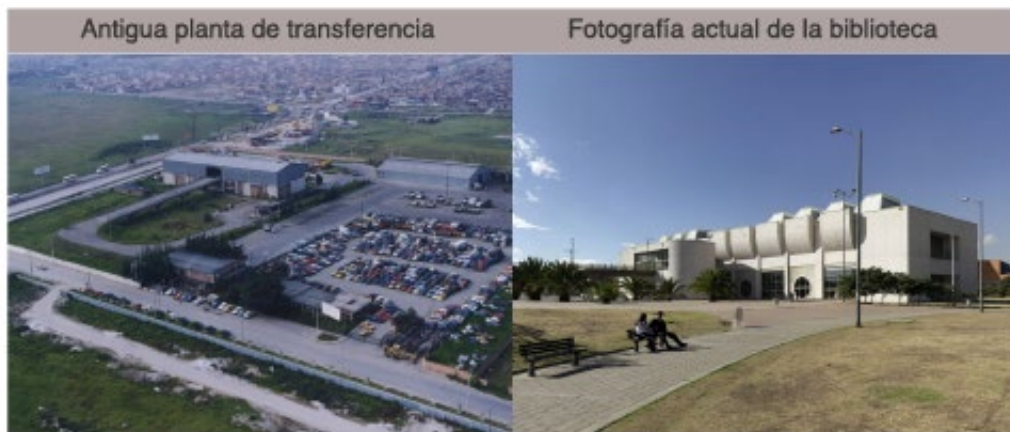
Figura 7. Fotografías comparativas de edificación original y biblioteca pública.
