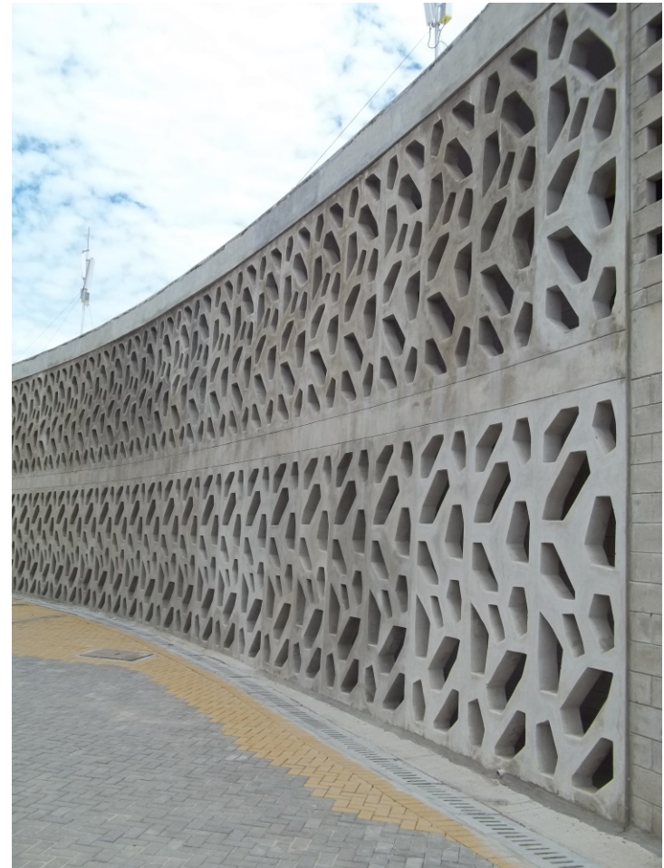
Imagen 37, Terminado Fachada Referente
