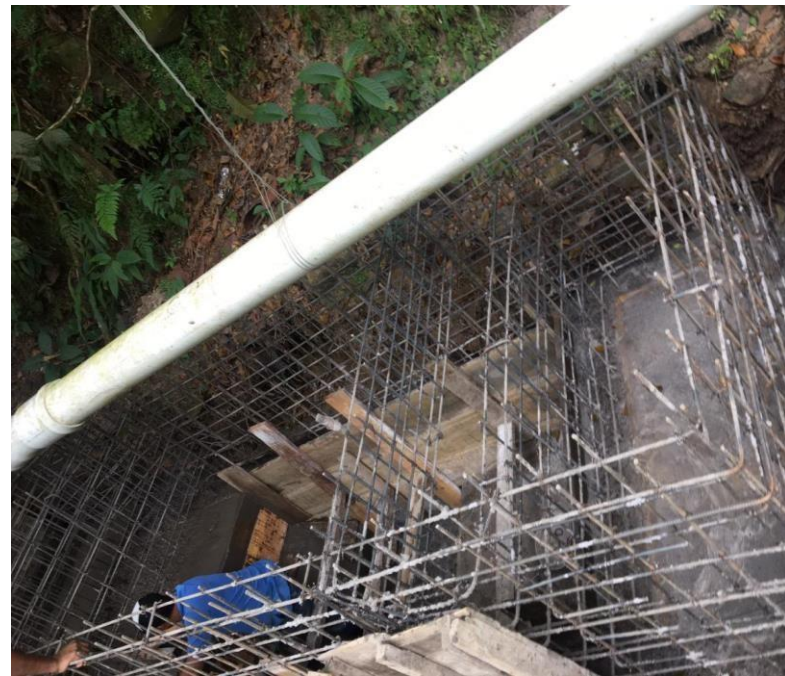
Figura 29. Construcción desarenador vista B
