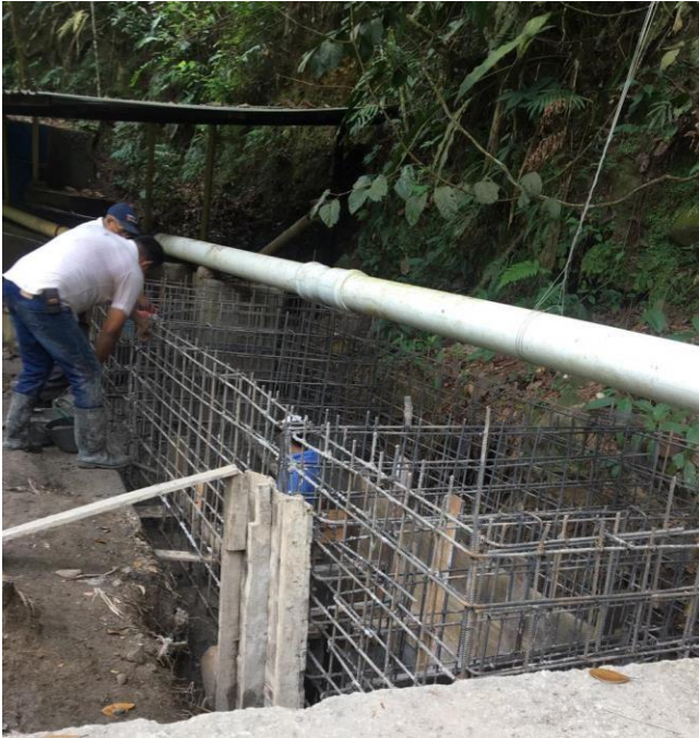
Figura 28. Construcción desarenador vista A
