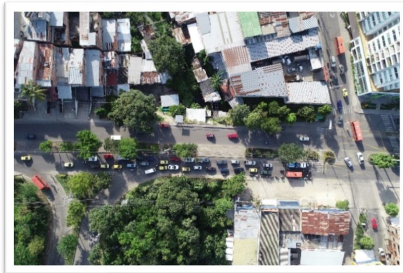
Figura 19. Foto Avenida Pedro Tafur calle 83 Ibagué Intersección Palermo
