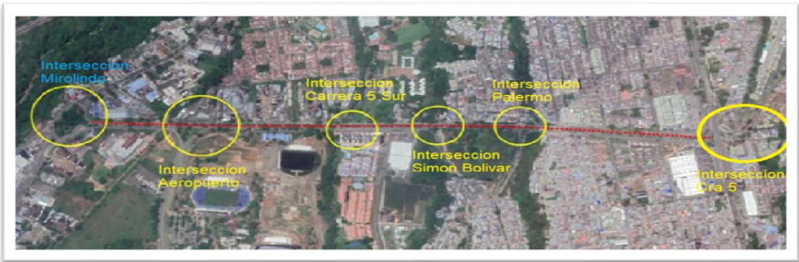
Figura 14. Foto aérea puntos críticos de la avenida Pedro Tafur calle 83 Ibagué
