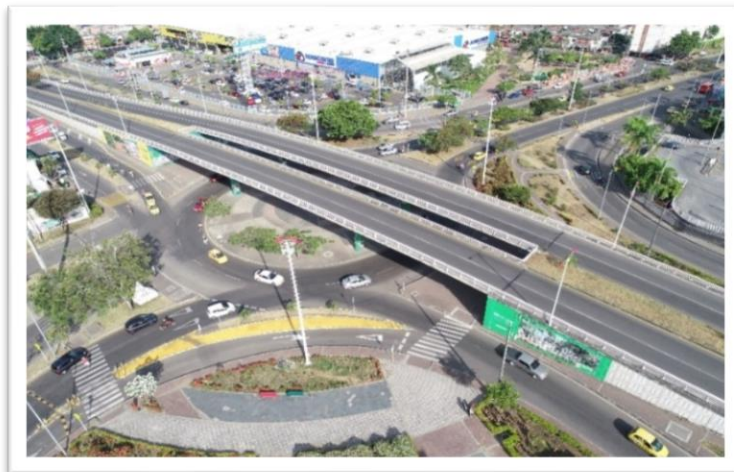
Figura 21. Foto Avenida Pedro Tafur calle 83 Ibagué intersección carrera 5
