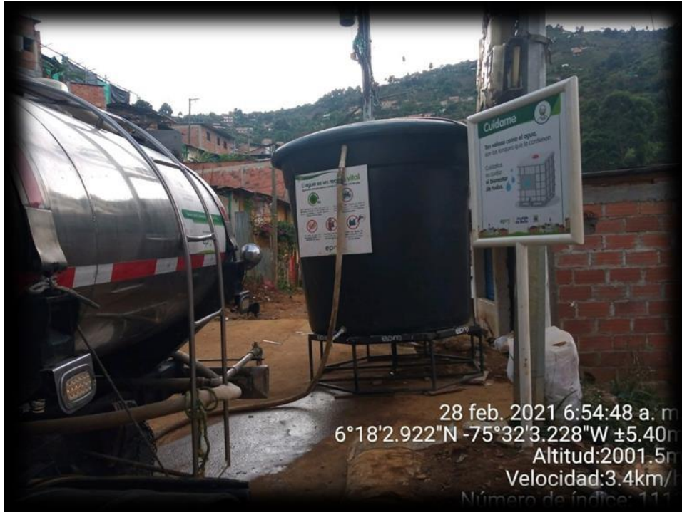
Figura 17. Suministro provisional de agua potable mediante carro tanque y tanque comunitario en Granizal (28 de febrero de 2021)
