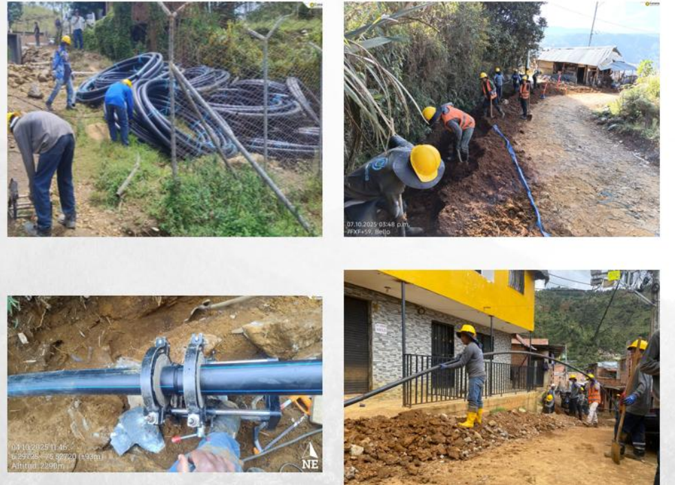
Figura 24. Instalación de la red de conducción en tubería PEAD mediante termofusión
