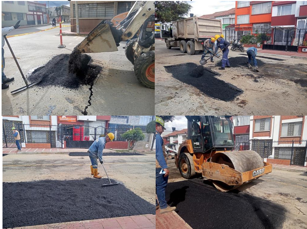
Figura 22. Instalación Asfalto para bacheo
