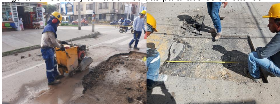
Figura 19. Cortes y toma de medidas para labores de bacheo
