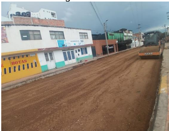
Figura 13. Instalación subbase granular cra 16 entre calles 11 y 11ª
