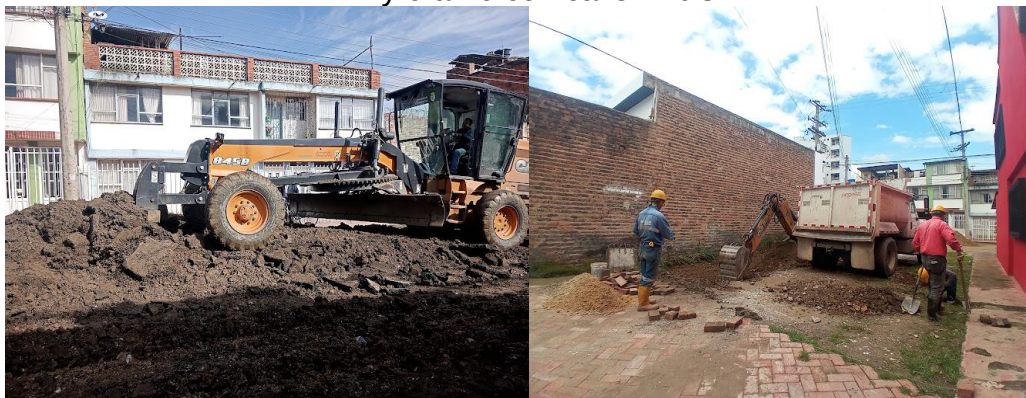
Figura 10. Excavación mecánica rehabilitación malla vial cra 16 entre calles 11 y 11ª y cra 16 con calle 11bis
