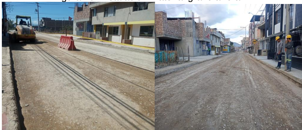
Figura 29. Instalación material granular cra 21
