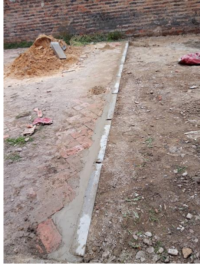
Figura 15. Instalación de bordillo A80 cra 16 con calle 11bis
