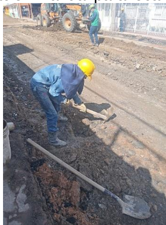
Figura 11. Excavación manual para localización de tubería
