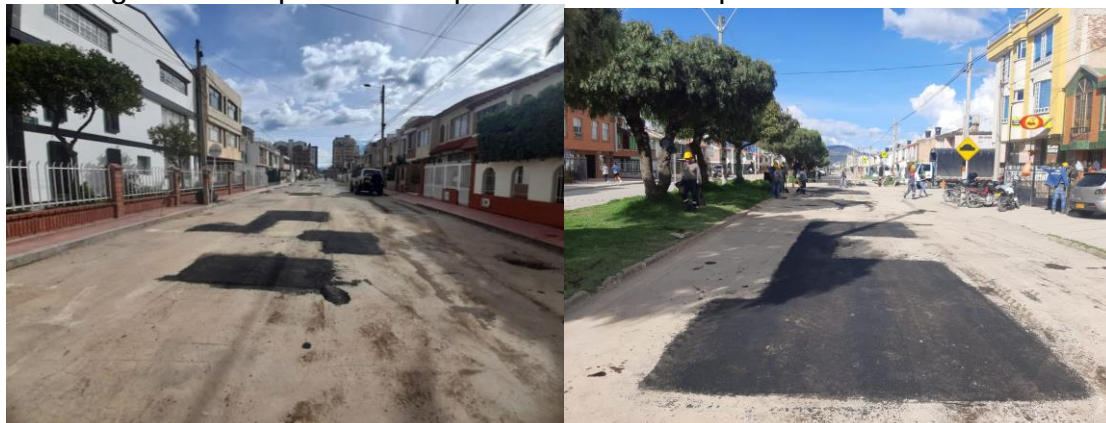
Figura 23. Reparación de pavimento flexible por medio de bacheo
