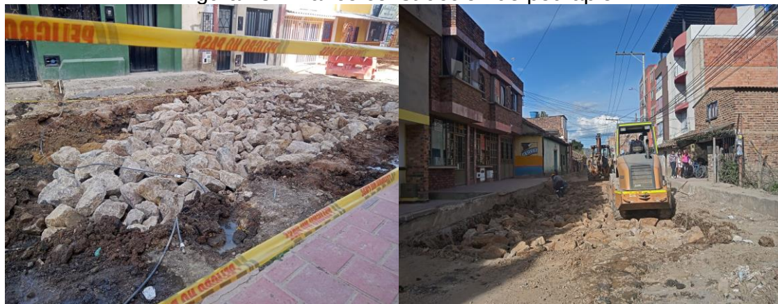
Figura 28. Avance construcción de pedraplén
