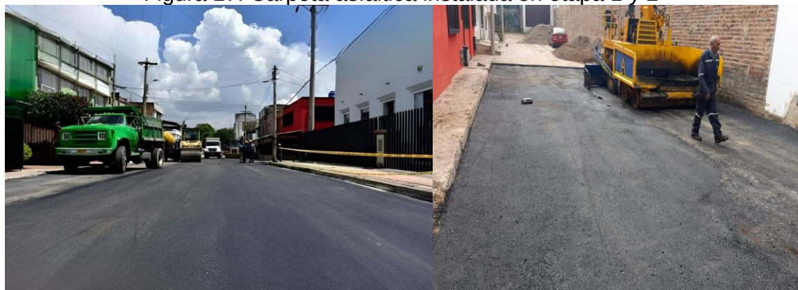
Figura 17. Carpeta asfáltica instalada en etapa 1 y 2
