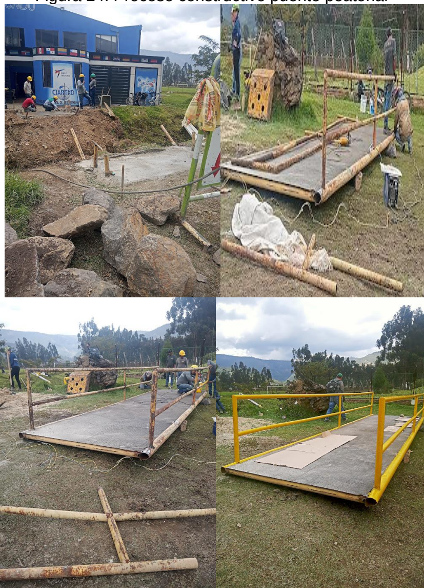
Figura 24. Proceso constructivo puente peatonal
