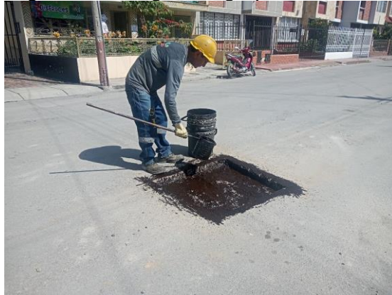
Figura 21. Riego de liga para bacheo
