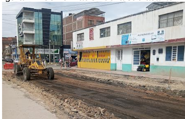
Figura 12. Conformación de la subrasante
