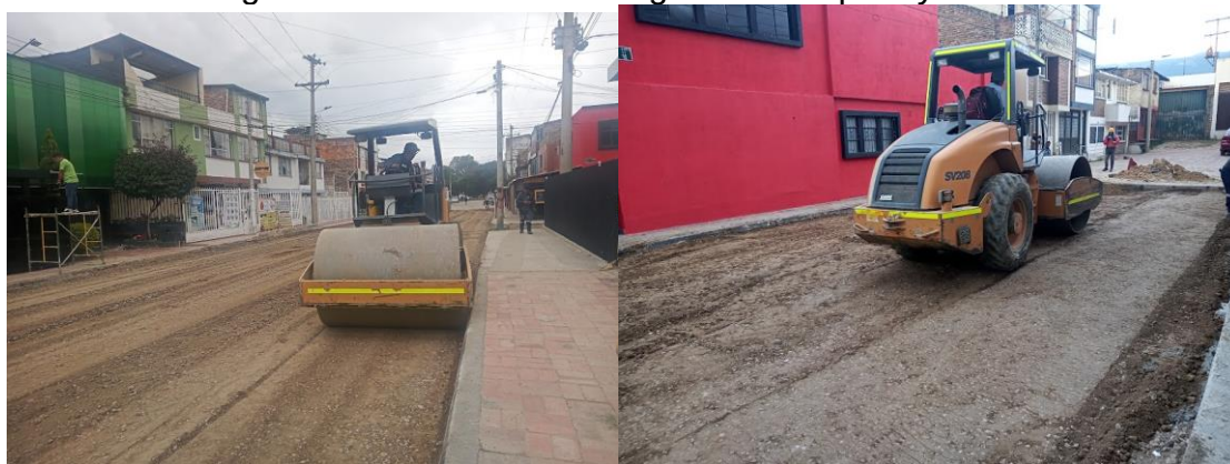
Figura 14. Instalación base granular etapa 1 y 2
