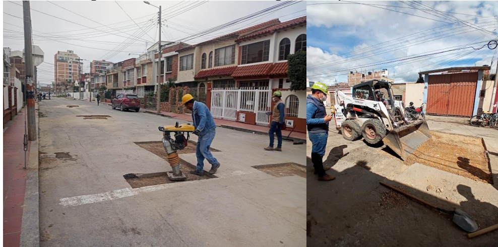
Figura 20. Instalación base granular para bacheo
