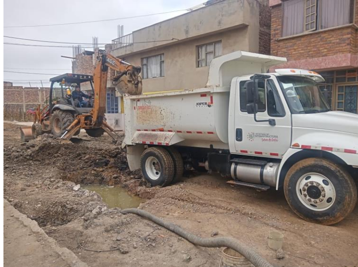
Figura 27. Excavación mecánica cra 21 con calle 24
