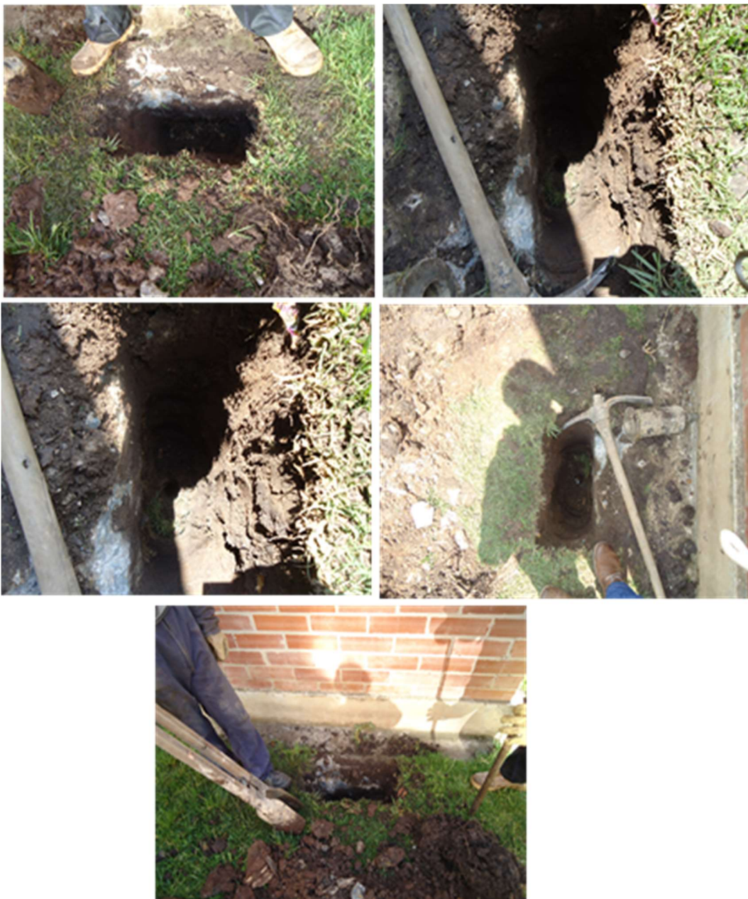
Foto 9 Cimentación costado occidental.
