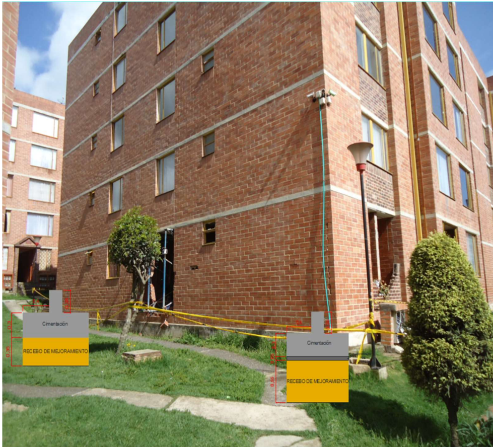
Esquema 18 Sistema de cimentación implantado en la torre 8.
