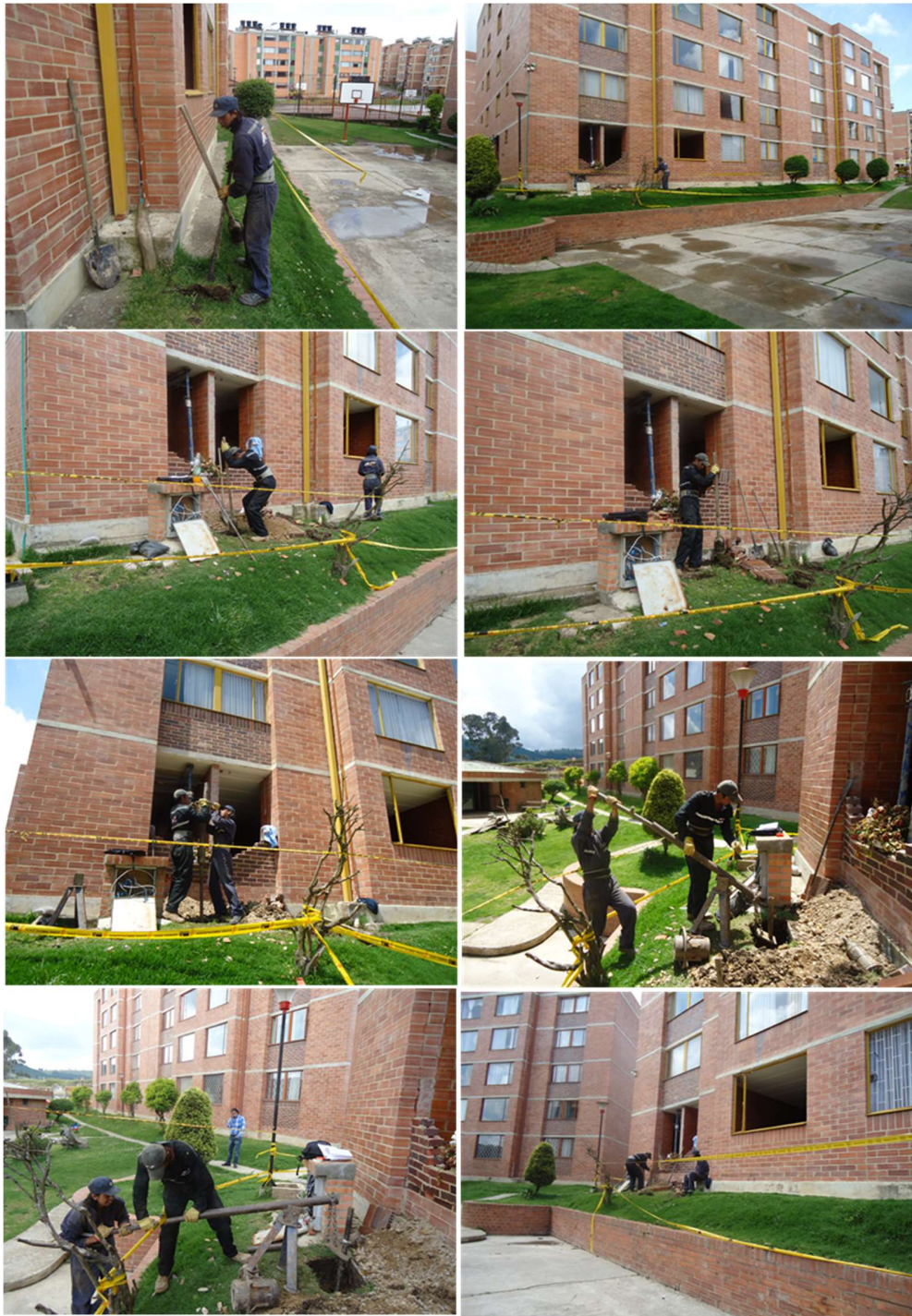
Exploración manual con recuperación de muestras alteradas e inalteradas.
