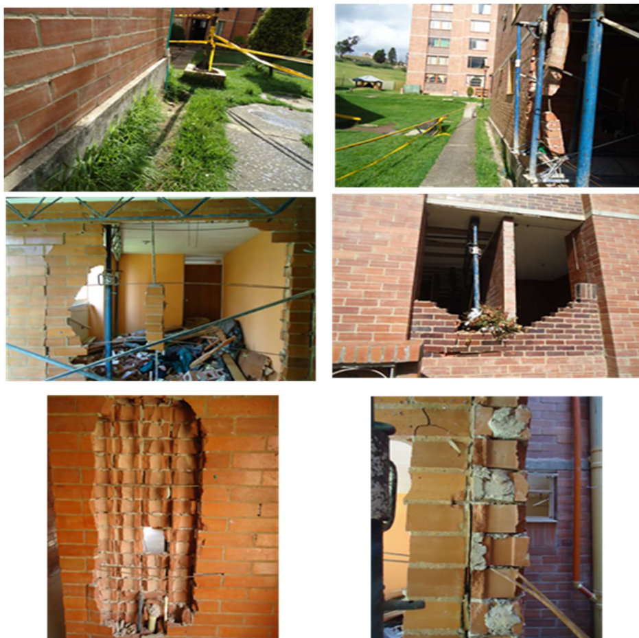
Foto 1 Estado actual del bloque 8.
