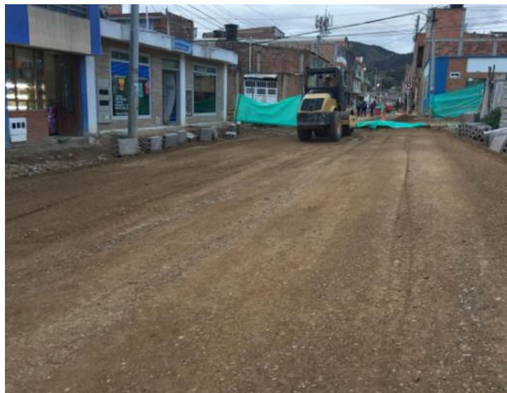
Ilustración 15. Compactación base Granular
