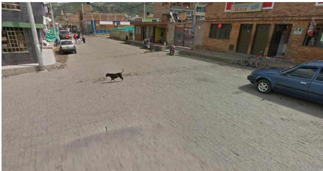
Ilustración 5. Estado inicial vía calle 4a
