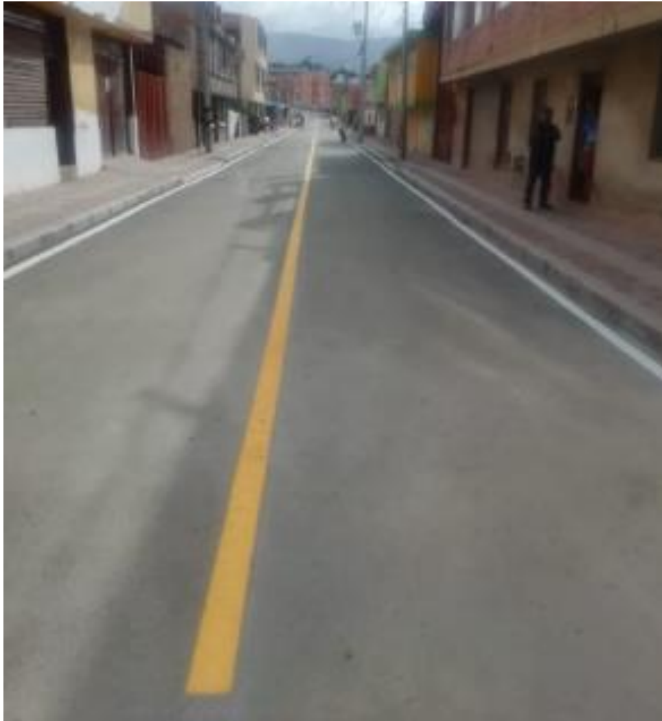
Ilustración 24. Carpeta asfáltica calle 5
