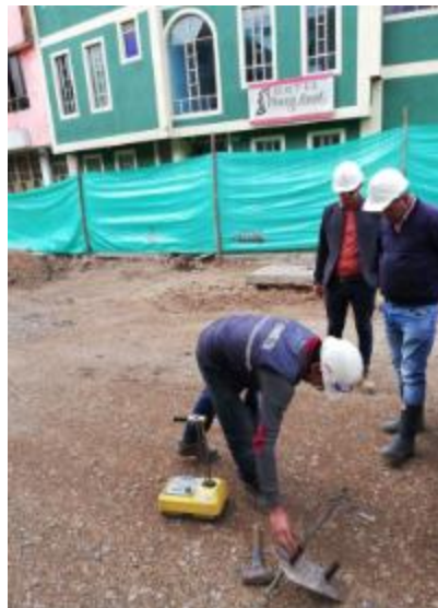
Ilustración 28. Verificación toma de densidades base granular
