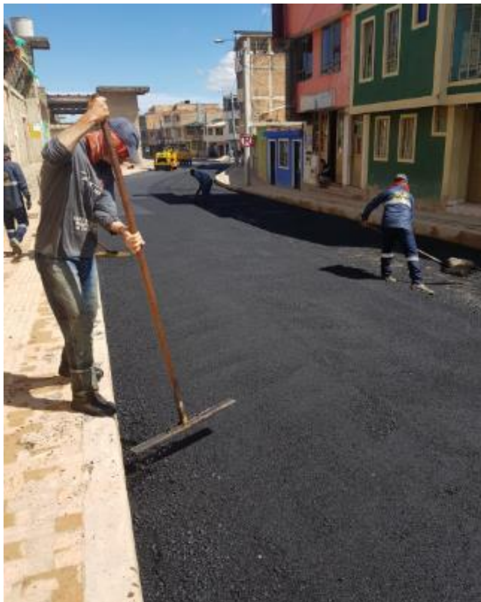
Ilustración 23. Construcción carpeta asfáltica con ayuda de niveletas
