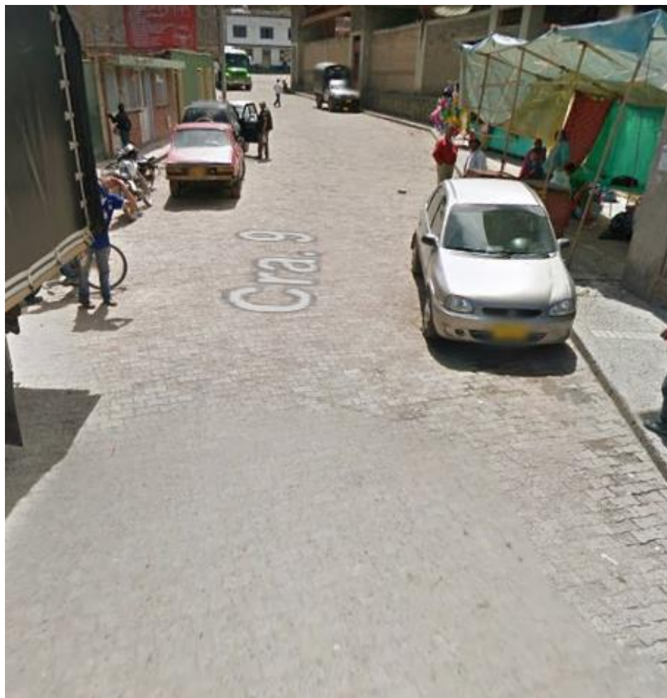
Ilustración 4. Estado inicial vía carrera 9a
