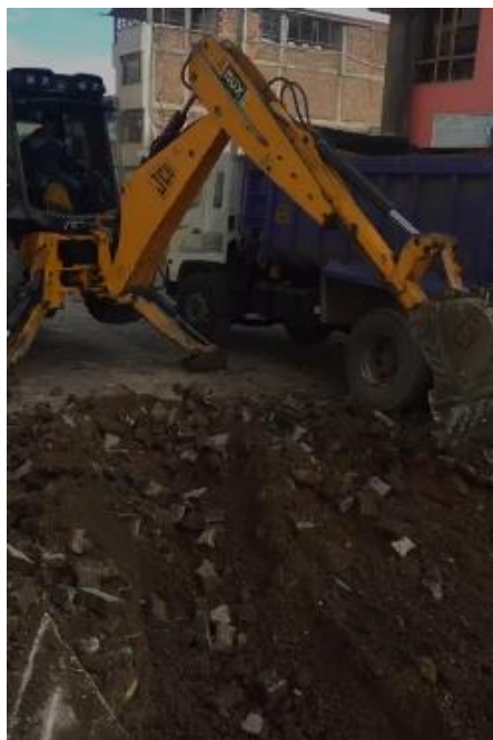
Ilustración 9. Excavación mecánica
