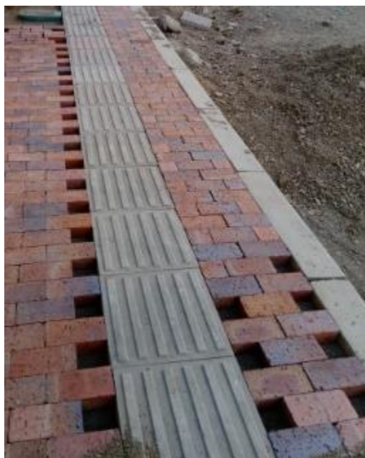
Ilustración 19. Instalación Adoquín gres
