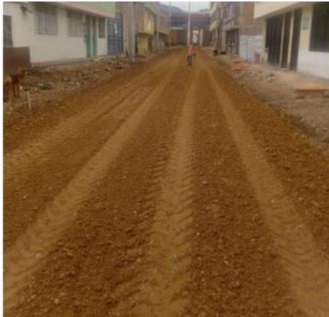
Ilustración 16. Suministro e instalación capa de base granular
