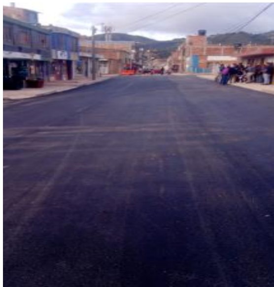
Ilustración 21. Imprimación emulsión asfáltica
