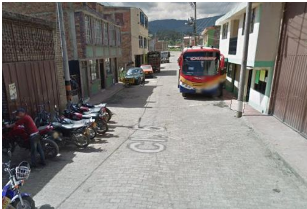
Ilustración 6. Estado inicial vía calle 5a
