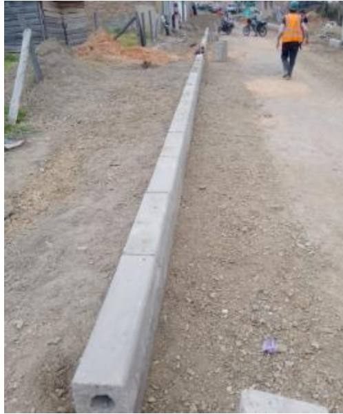
Ilustración 17. Instalación de sardinel prefabricado A-10
