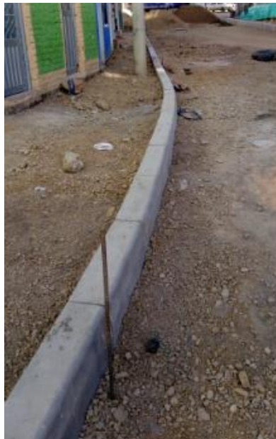
Ilustración 18. Instalación de sardinel prefabricado A-10
