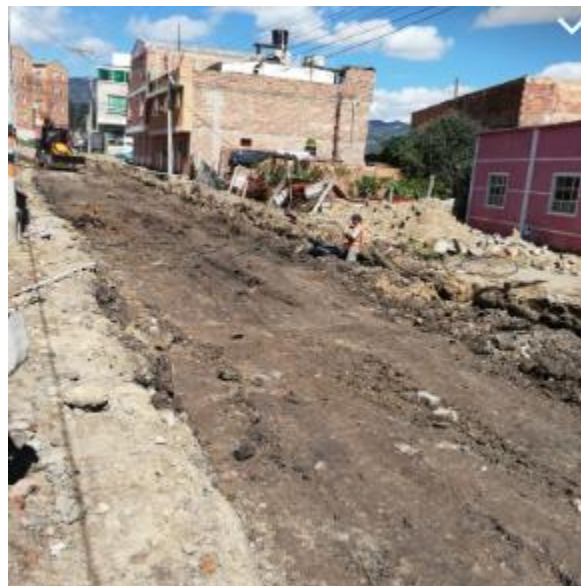
Ilustración 10. Demolición pisos y andenes
