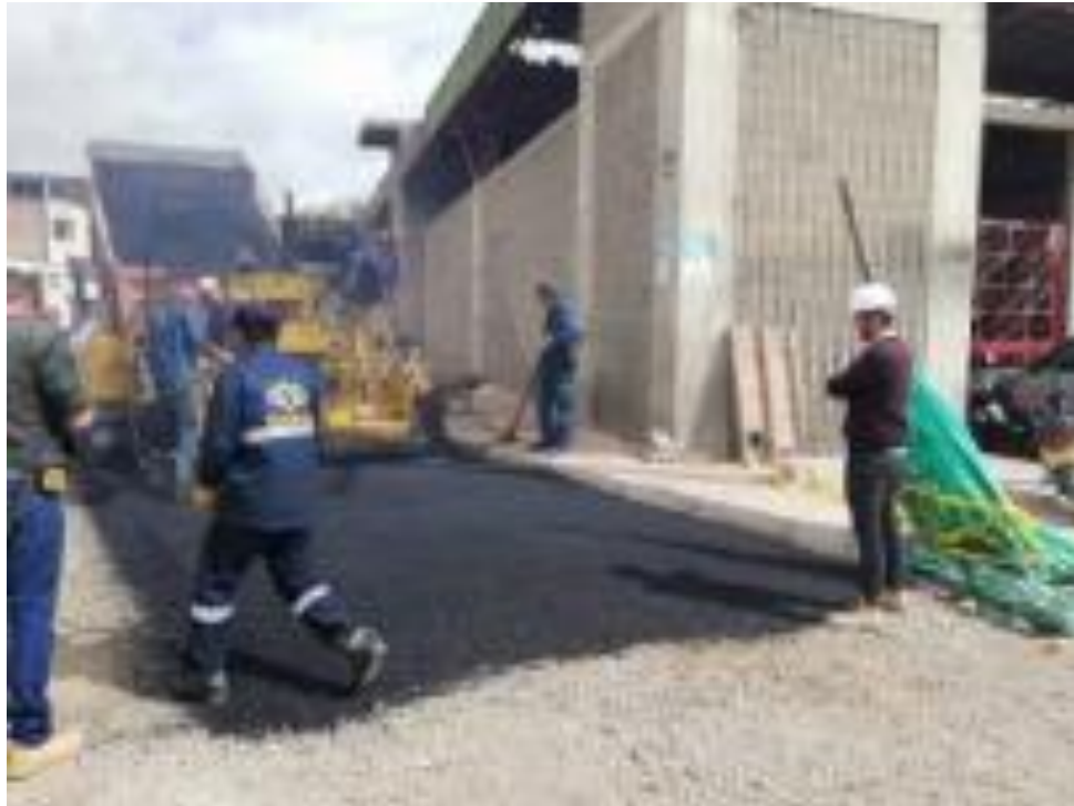
Ilustración 29. Apoyo en verificación de la instalación de la carpeta asfáltica
