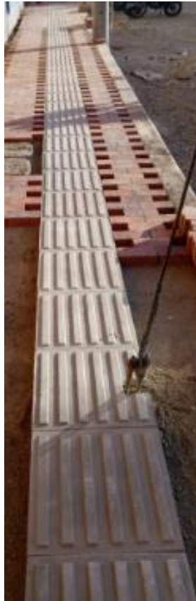
Ilustración 20. Instalación tableta A-10
