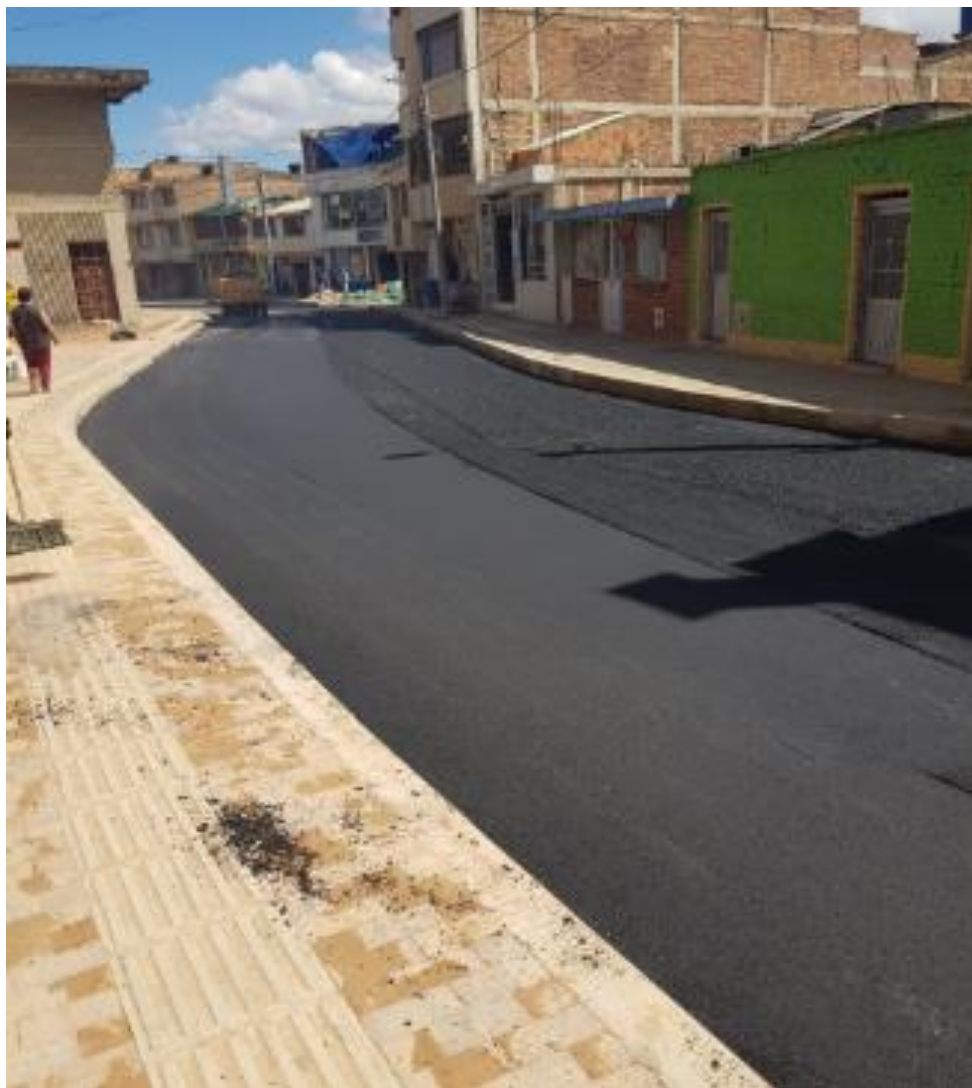
Ilustración 22. Construcción de la carpeta asfáltica
