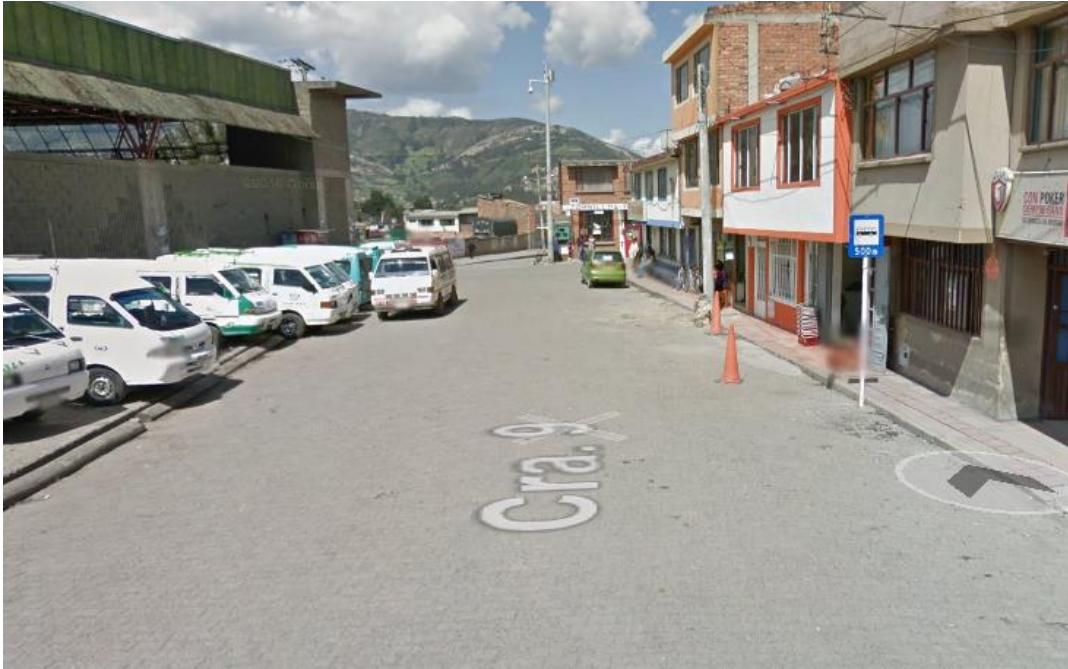
Ilustración 3. Estado inicial vía carrera 9a
