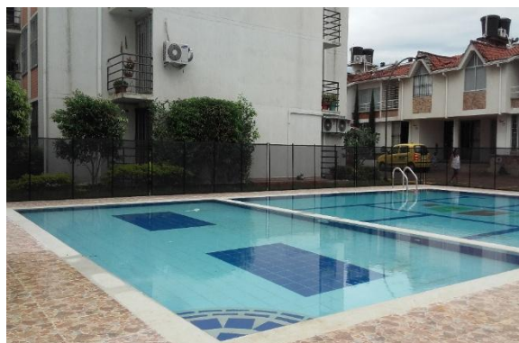
Figura 10. Estado actual de la piscina
