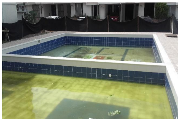
Figura 9. Estado antiguo de la piscina
