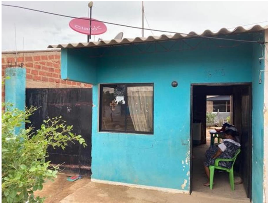
Figura 28. Vivienda de interés social Yosuu.
