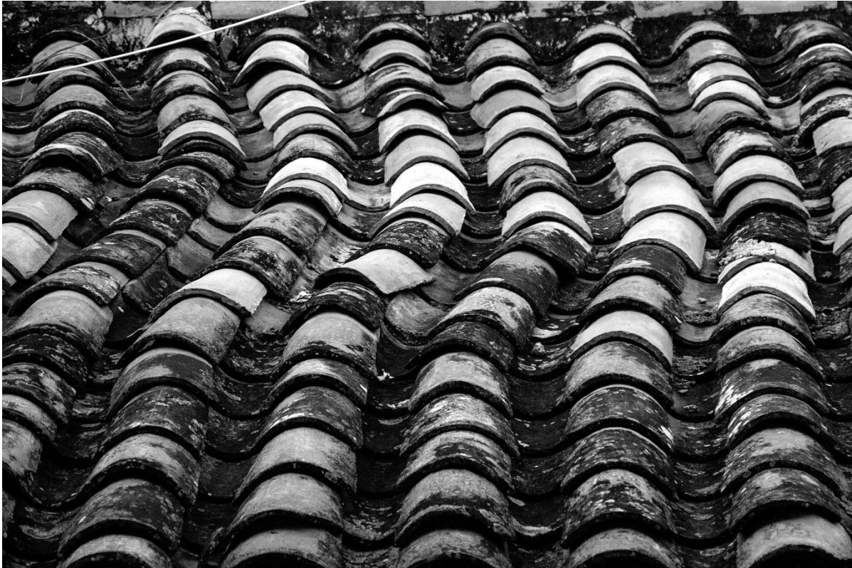
Tejado de casa San Alonso – Bucaramanga
