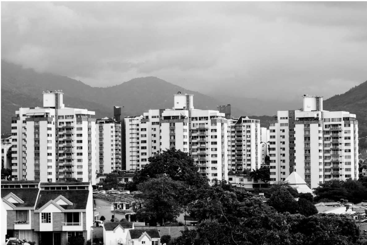
Conjunto Residencial Parque Central barrio Cañaveral - Floridablanca
