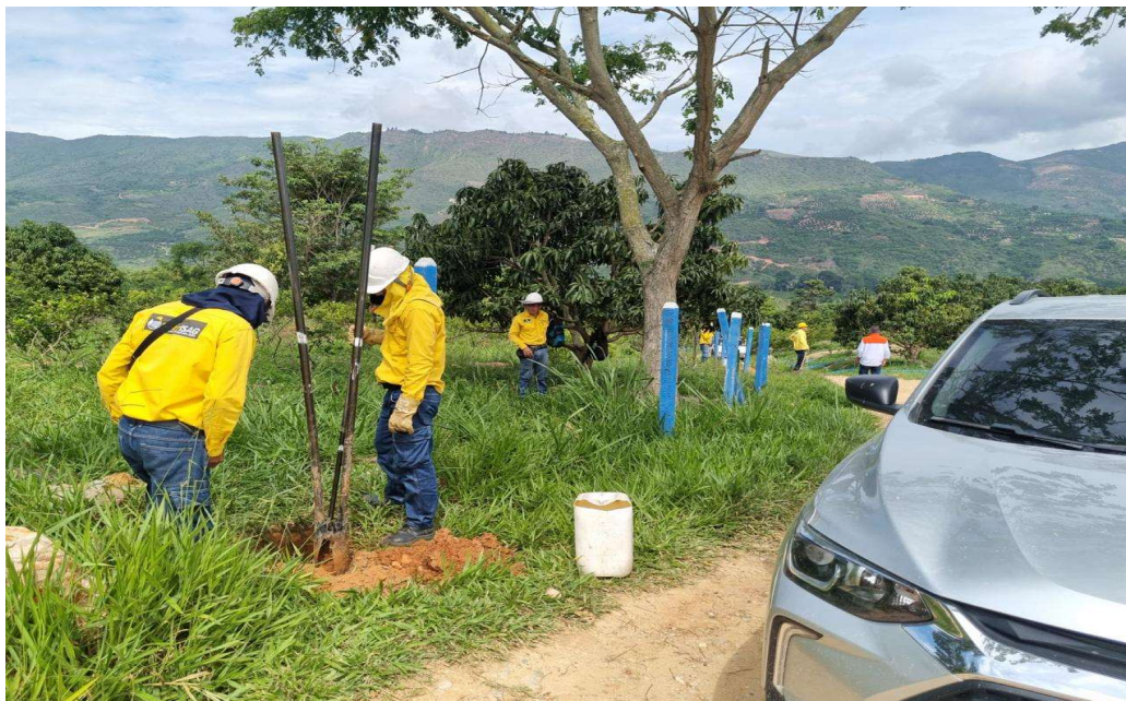
Figura 15. Preparación del terreno para la instalación de postes de soporte de la red de fibra óptica aérea.
