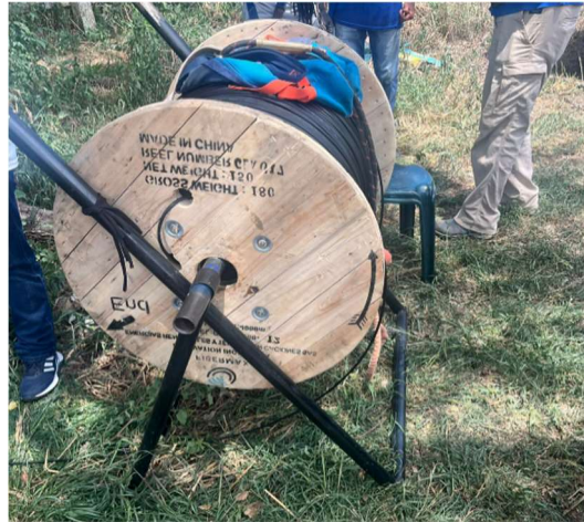
Figura 14. Despliegue en campo de bobina de fibra óptica para el tendido aéreo en la vereda Chocoita.
