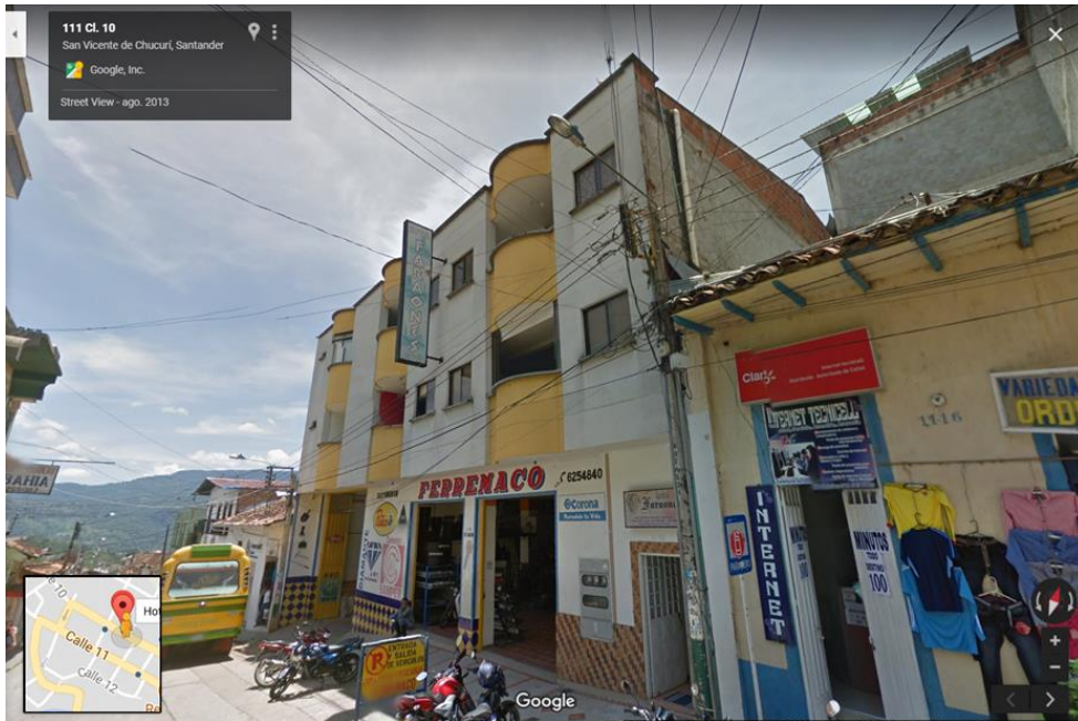
Figura 4. Fotografía del hotel Faraones
