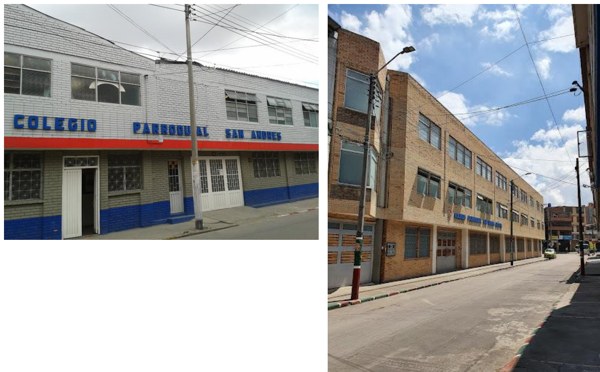
Figura 4. Antigua infraestructura del colegio (izquierda) vs remodelación (derecha)
