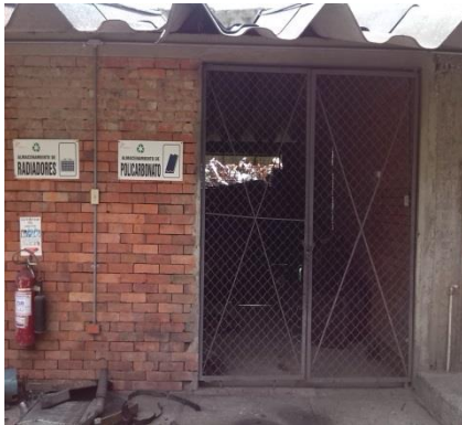
Almacenamiento de radiadores
