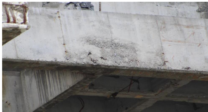
Ilustración 13. hormigueros en estructura fuente consorcio estadio 2014
