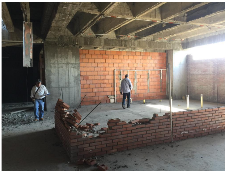
Ilustración 23. proceso de mampostería
