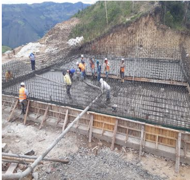
Fotografía 4. Losa de cimentación impermeabilizada con juntas constructivas flexibles
