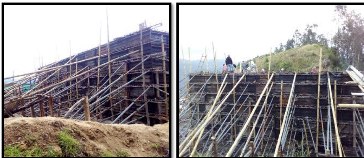
Fotografía N° 03: CAMILLAS, CERCHAS Y PUNTALES METALICOS.
