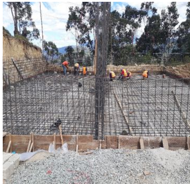
Fotografía 6. Anclajes en concreto
