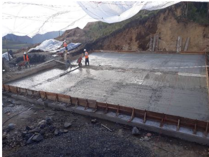
Foto 6. Fundicion y terminado de placa en concreto ciclopeo 40% rajo 60% concreto simple
