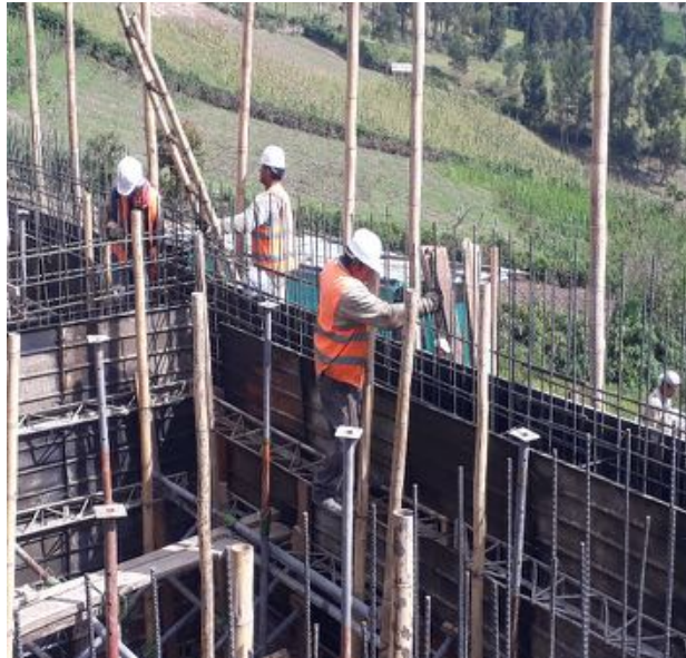
Fotografía 7. Acero de refuerzo 420 Mpa
