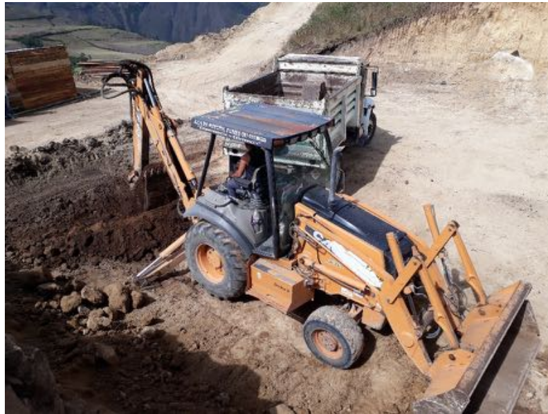
Foto 1. Excavacion de material comun
