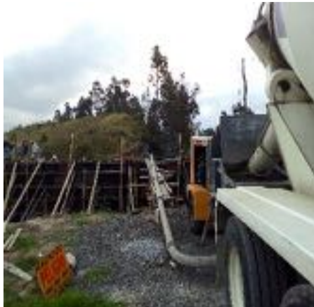
Fotografía 5. Muro de concreto armado impermeabilizado
