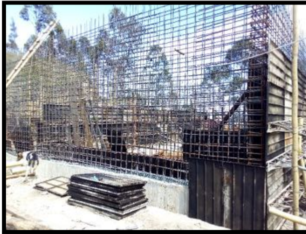
Fotografía N° 01: ACERO DE REFUERZO.
