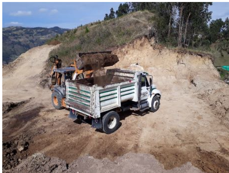
Foto 2. Carga de material proveniente de la excavacion
