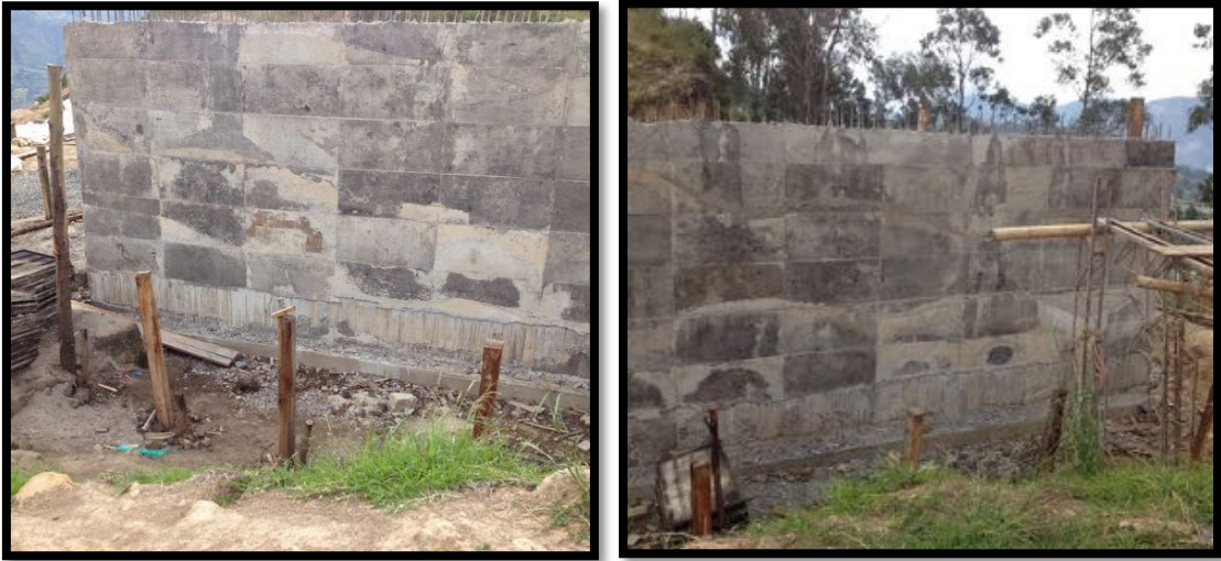
Fotografía N° 05: MUROS UNA VEZ DESENCOFRADOS
