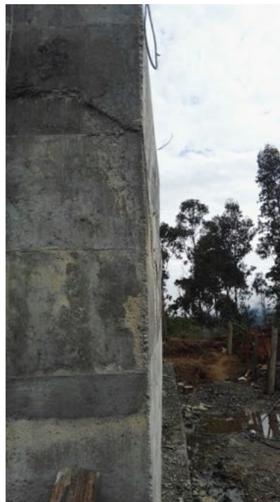
Desplazamiento de formaleta.
