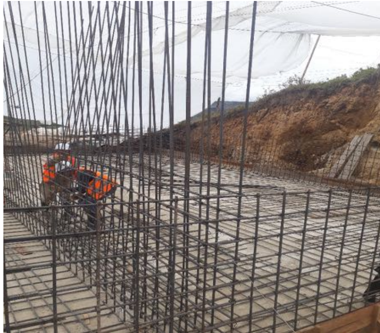
Foto 9. Despiece muro central divisorio.
