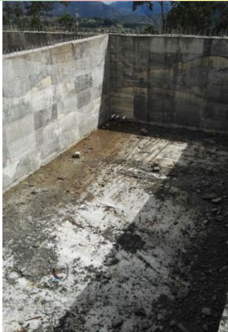
Área interior del tanque.
