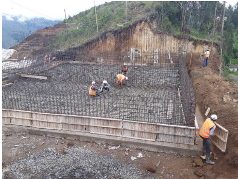
Foto 10. Enconfrado para muro en concreto armado impermeabilizado
