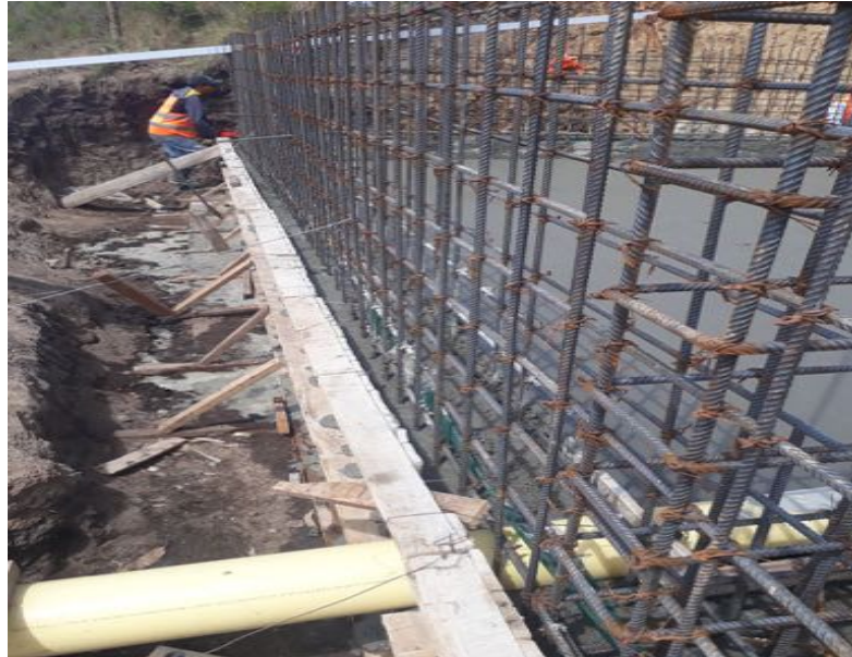
Foto11. Vaciado de concreto para los diferentes muros del tanque
