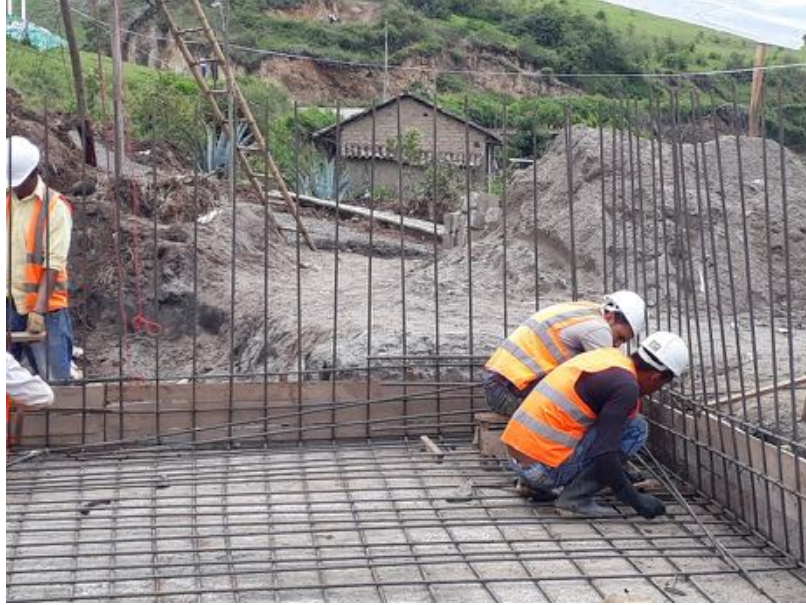
Foto 7. Despiece para muro en concreto armado
