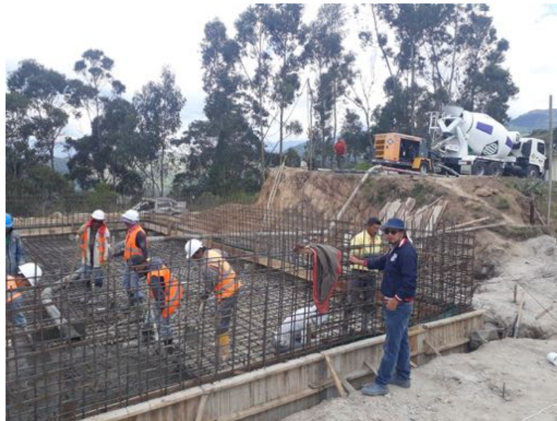
Foto12. Vaciado del concreto para la placa de 4000 PSI
