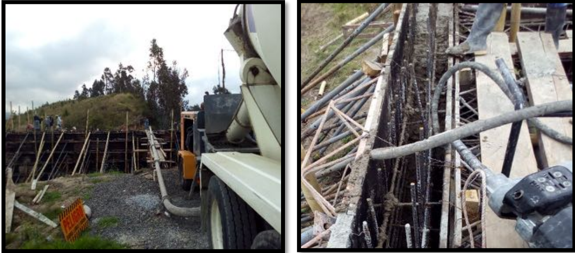
Fotografía N° 04: FUNDICION DE CONCRETO PREMEZCLADO DE 4000 PSI
