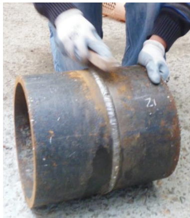
Figura 25 Limpieza superficial del tubo
