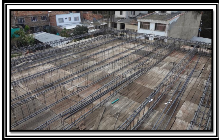
Ilustración 11 Amarre de acero para placa; vigas viguetas
