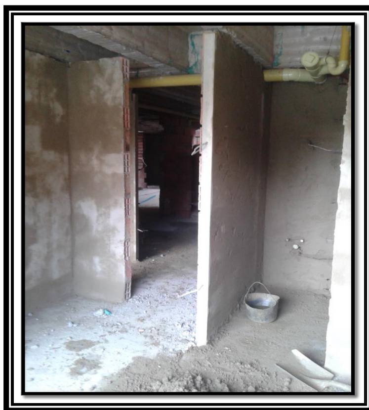
Ilustración 28 Instalación de pañete sobre muro
