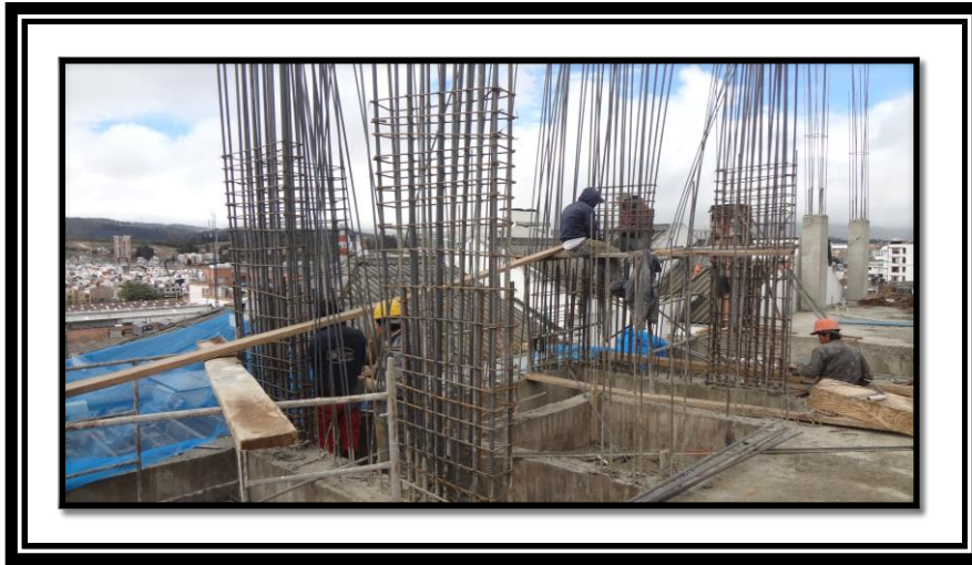
Ilustración 14 Cuadro 16 Instalación de acero muro pantalla ascensor
