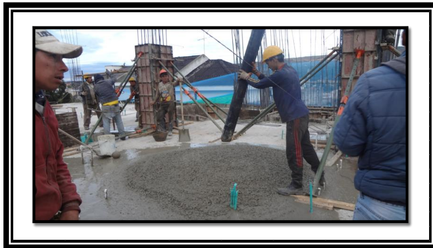
Ilustración 19 Proceso de fundición en concreto de columnas
