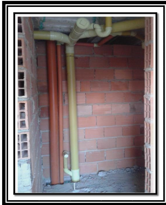
Ilustración 23 Ejemplo, bajante de aguas lluvia y sanitaria
