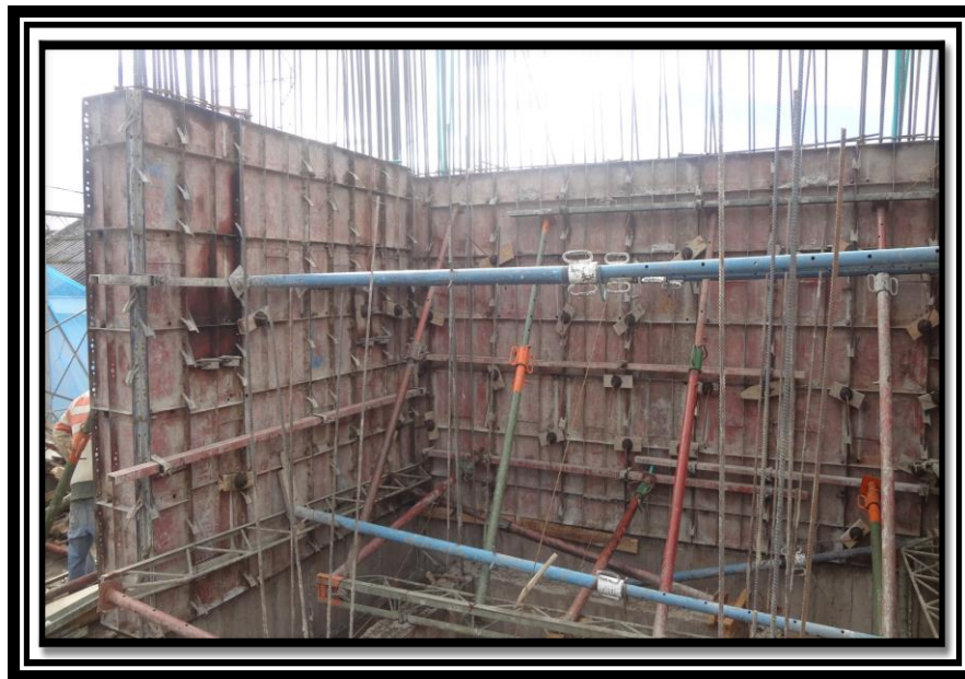
Ilustración 10 Instalación de formaleta para muro pantalla de ascensor
