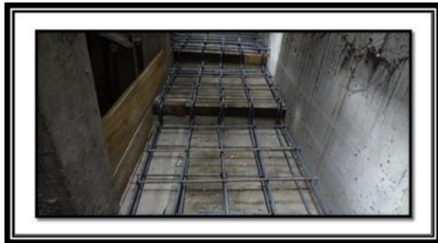
Ilustración 17 Tramo 2 escalera, refuerzos transversales y peldaños
