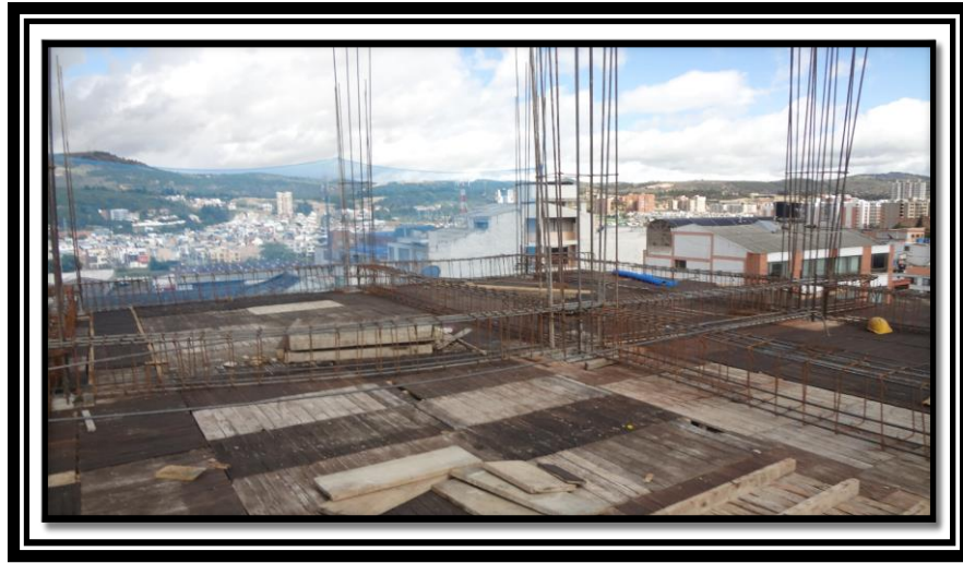
Ilustración 13 Amarre de acero para columnas
