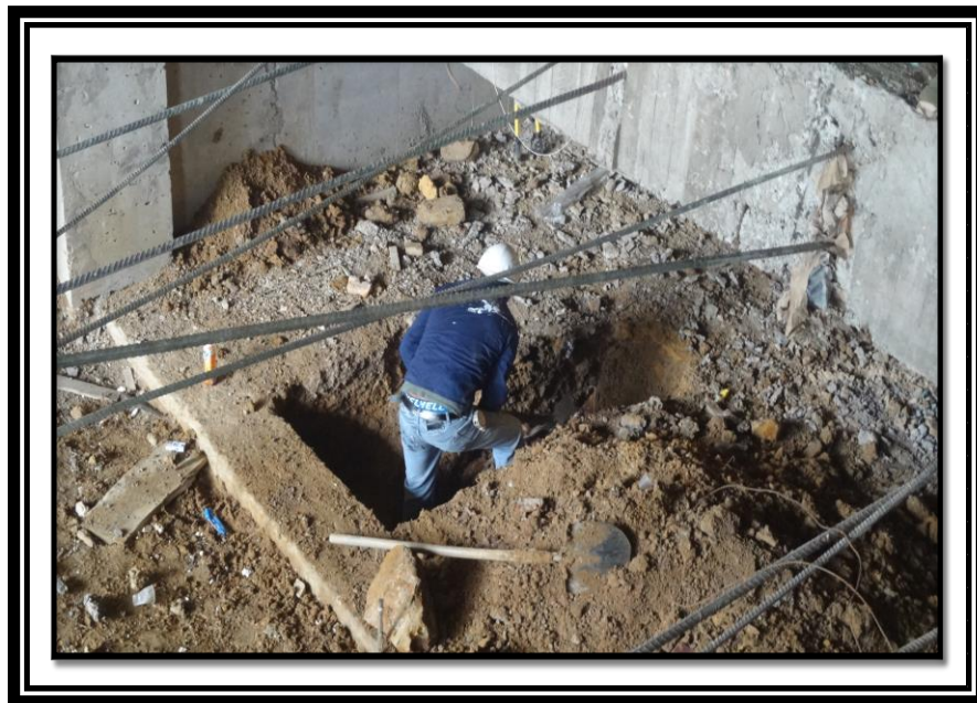
Ilustración 30 Excavación red de desagüe sumidero inferior de rampa
