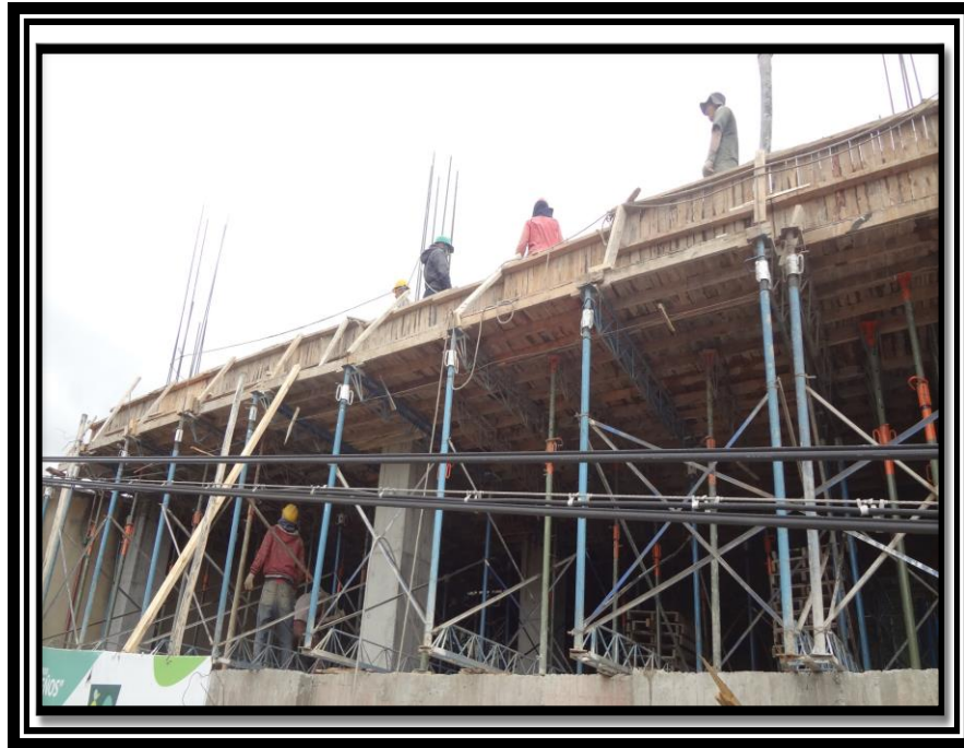
Ilustración 7 Sistema de formaleta para confinamiento de placa
