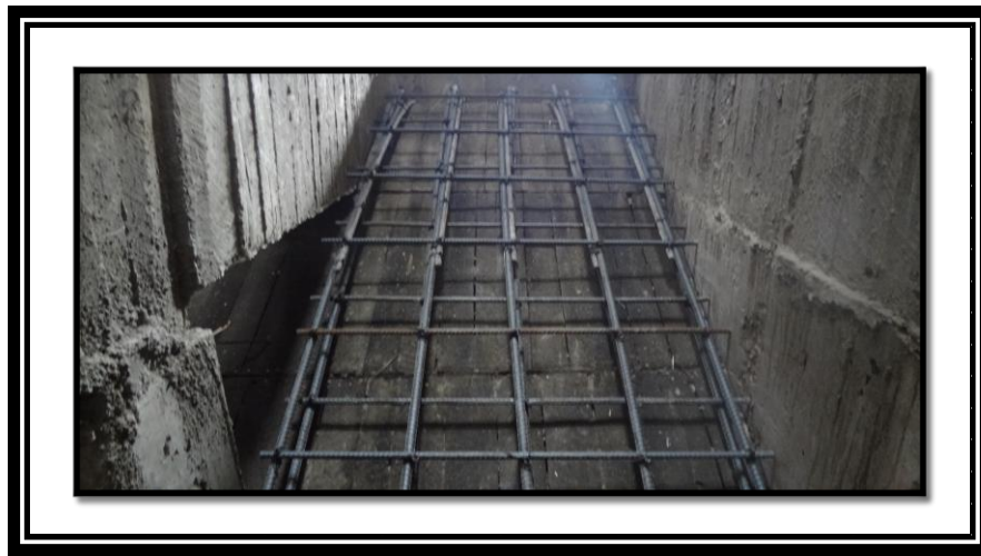
Ilustración 16 Tramo 1 escalera, refuerzos transversales y de peldaños
