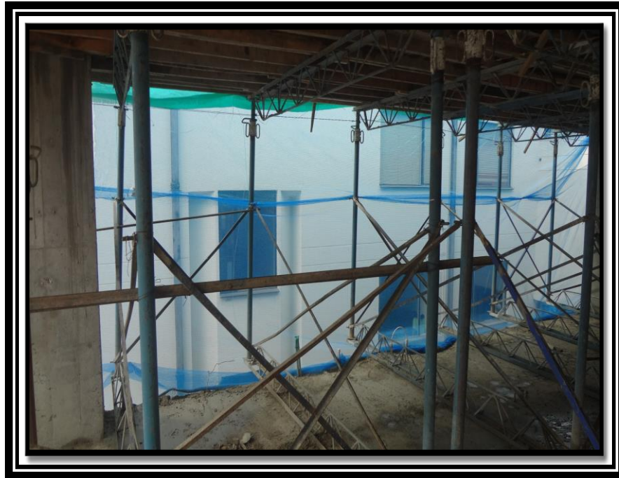
Ilustración 6 Formaleta de confinamiento de placa
