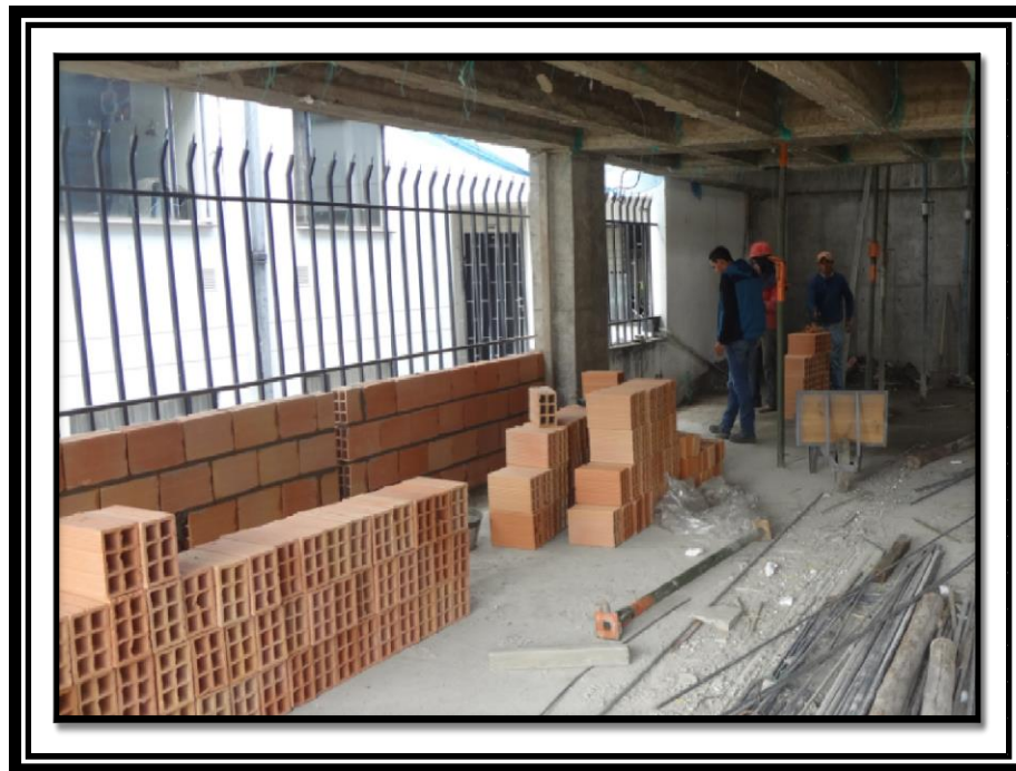
Ilustración 27 Ejemplo, instalación de bloque No 5; cerramiento perimetral nivel 2
