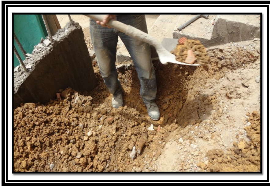
Ilustración 31 Excavación rampa de acceso principal discapacitados
