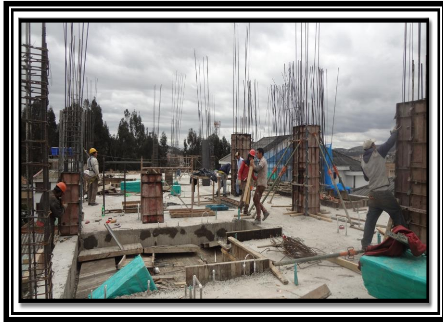
Ilustración 9 Instalación de formaleta para columnas edificio ALTOS DE SAN FERNANO
