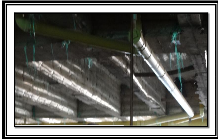
Ilustración 21 Ejemplo, instalación red sanitaria
