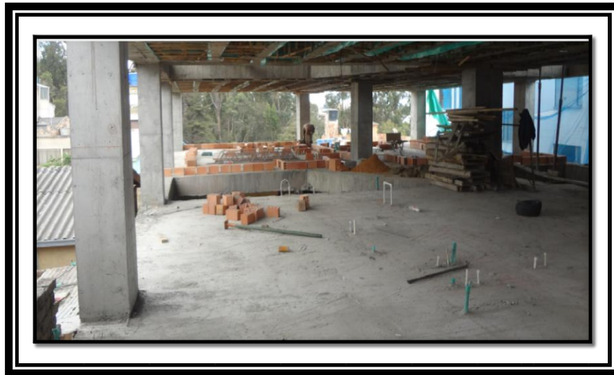
Ilustración 24 Ejemplo, zona de replanteo de apartamentos y zonas comunes nivel 2
