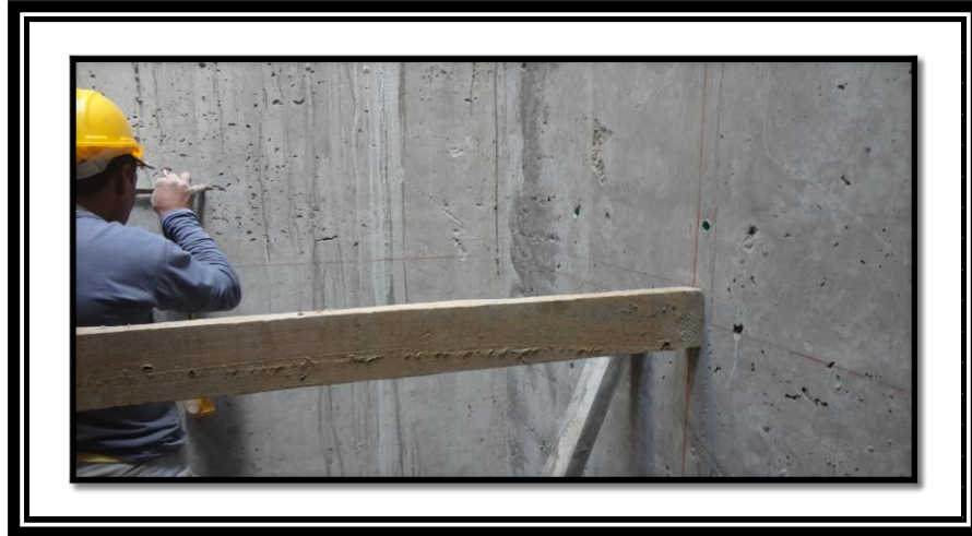
Ilustración 15 Trazado de escalera sobre muro pantalla
