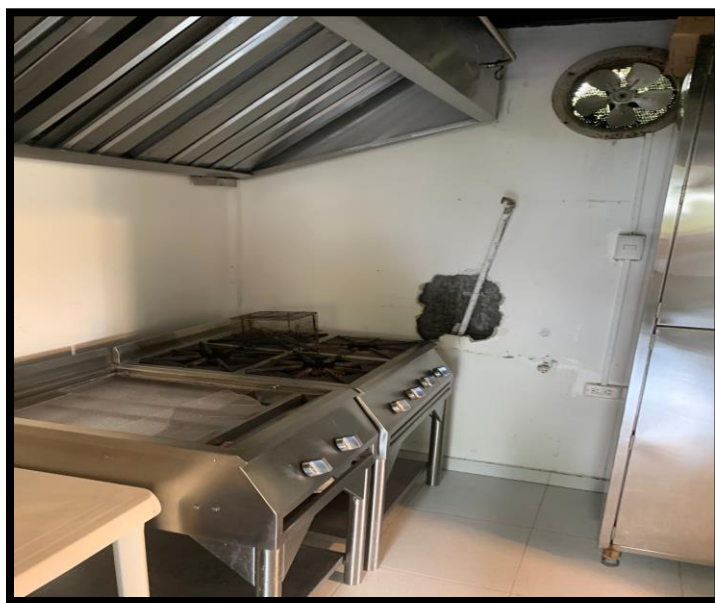
Figura 31. Área de preparación y cocción de alimentos restaurante CafeÚ
