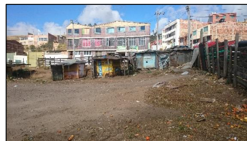
Figura 2. Zona deteriorada en la plaza
