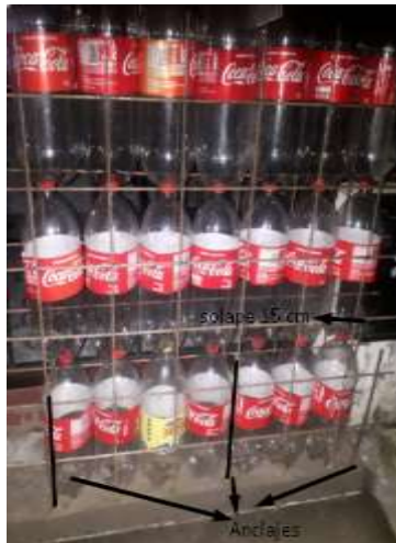
FIGURA. X MODELO MURO NO ESTRUCTURAL CON ENVASES 3 LITROS FUENTE: PROPIA
