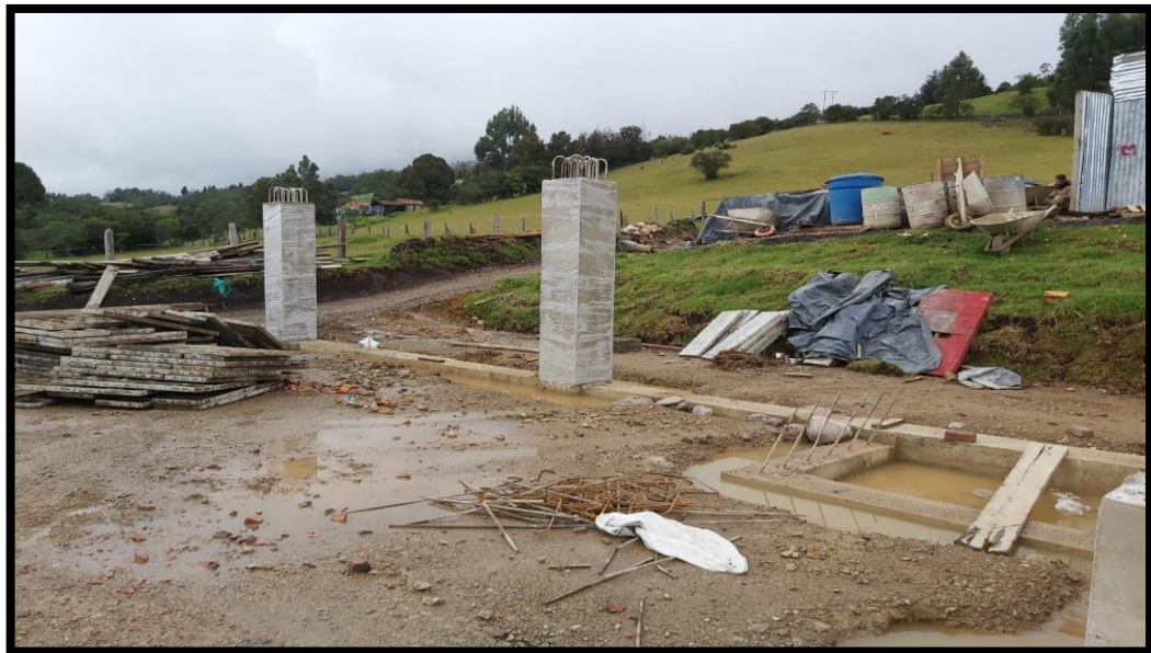
Figura 19. Fraguado de columnas de 50cm x 50cm.
