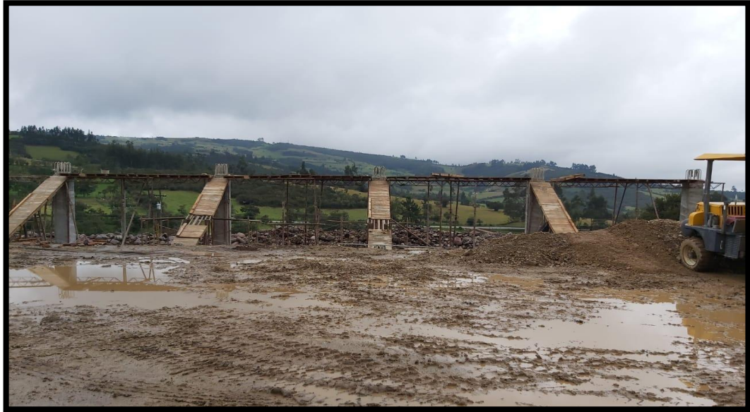
Figura 18. Instalación de formaletas, cerchas y parales.
