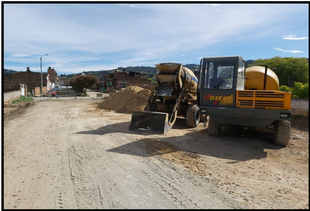
Figura 9. Maquinaria hormigonera para la mezcla del concreto.
