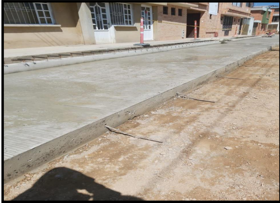
Figura 16. Cepillado y curado de la placa.
