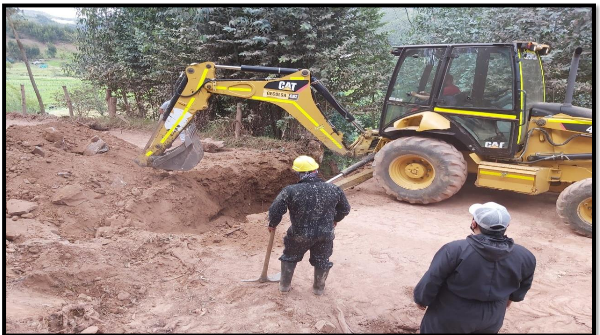
Figura 25. Excavación mecánica para colocación de tubos de 36".
