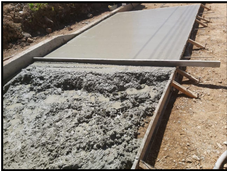
Figura 15. Nivelación y vibración del concreto.
