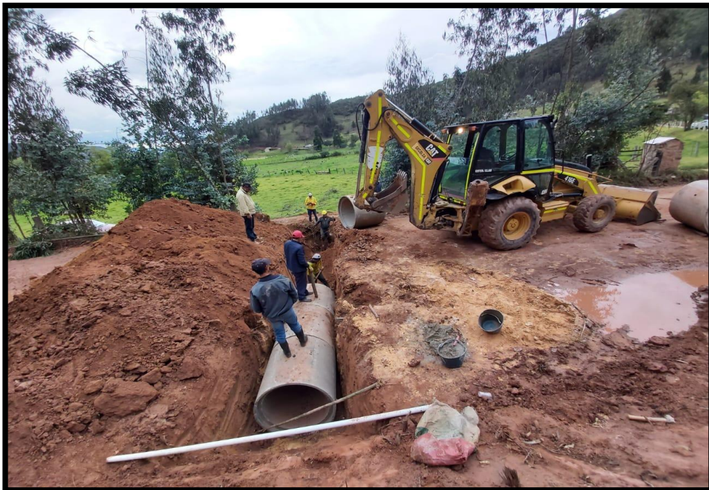
Figura 27. Excavación mecánica y colocación de tubo reforzado de 36".
