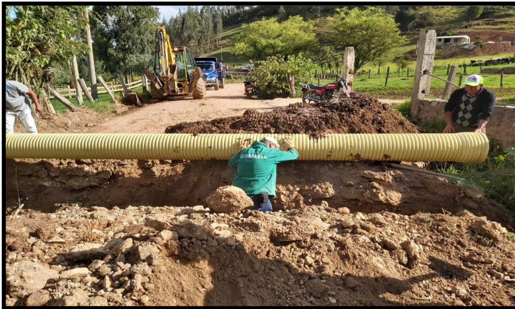
Figura 26. Colocación tubo corrugado Novafort.
