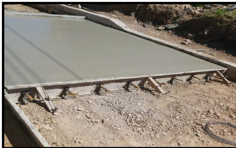
Figura 13. Fundición de placa de 2,5m x 2,0m.
