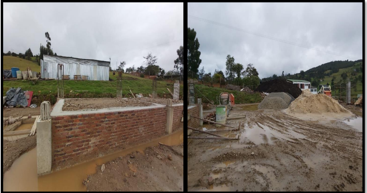
Figura 20. Construcción de la tarima y losa del CIC.
