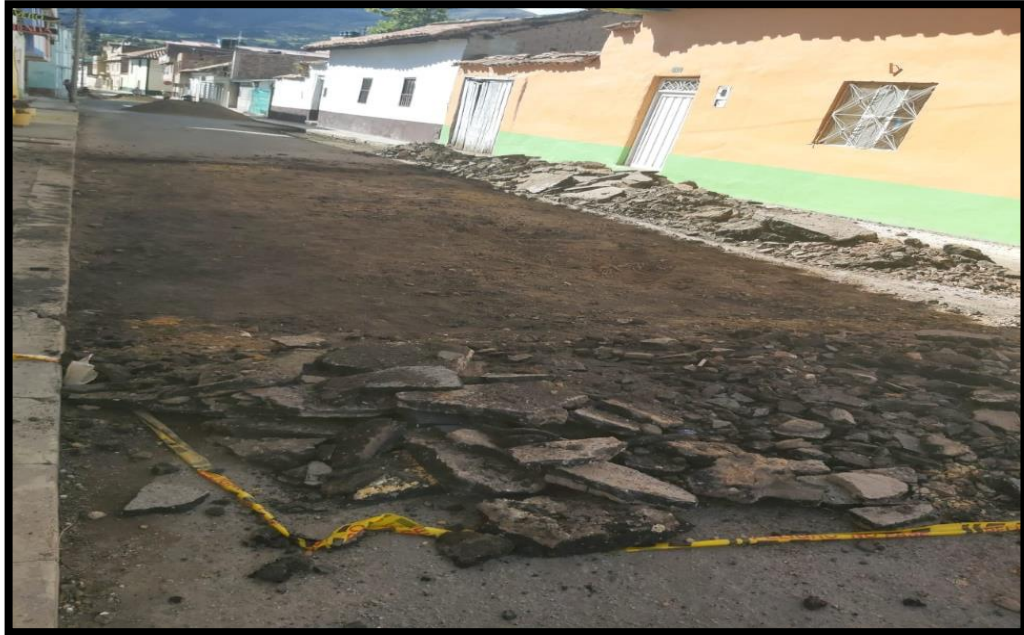
Figura 30: Retiro de material.
