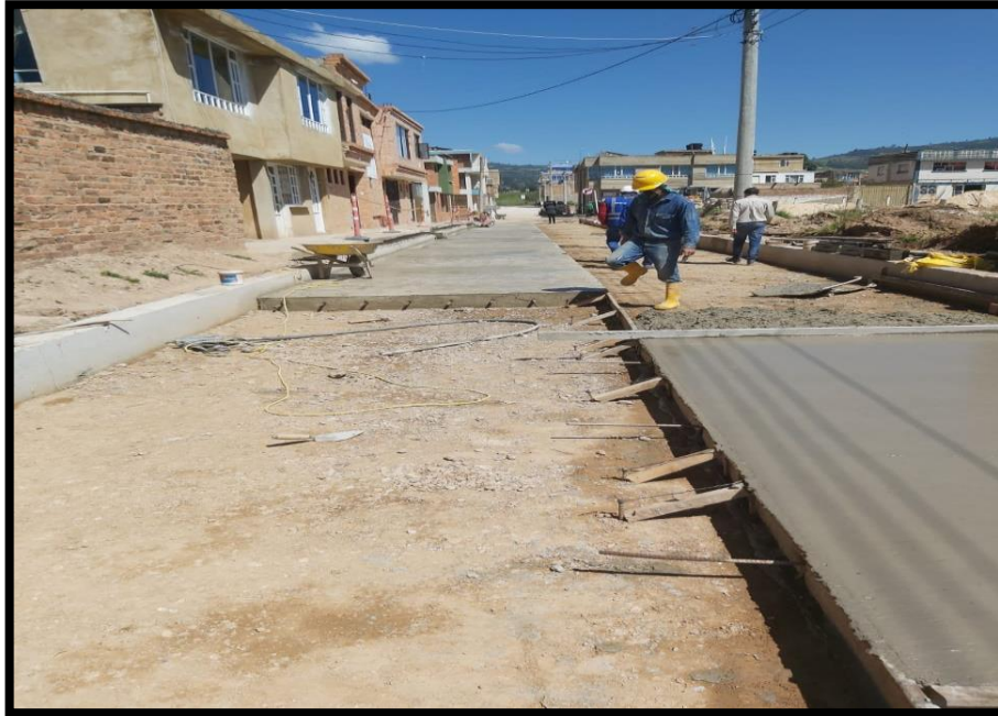
Figura 14. Fundición de placas e instalación de acero.
