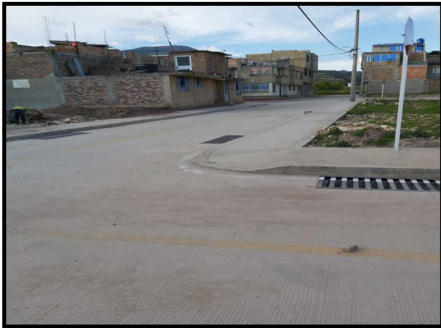
Figura 17. Resultado final del pavimento rígido.
