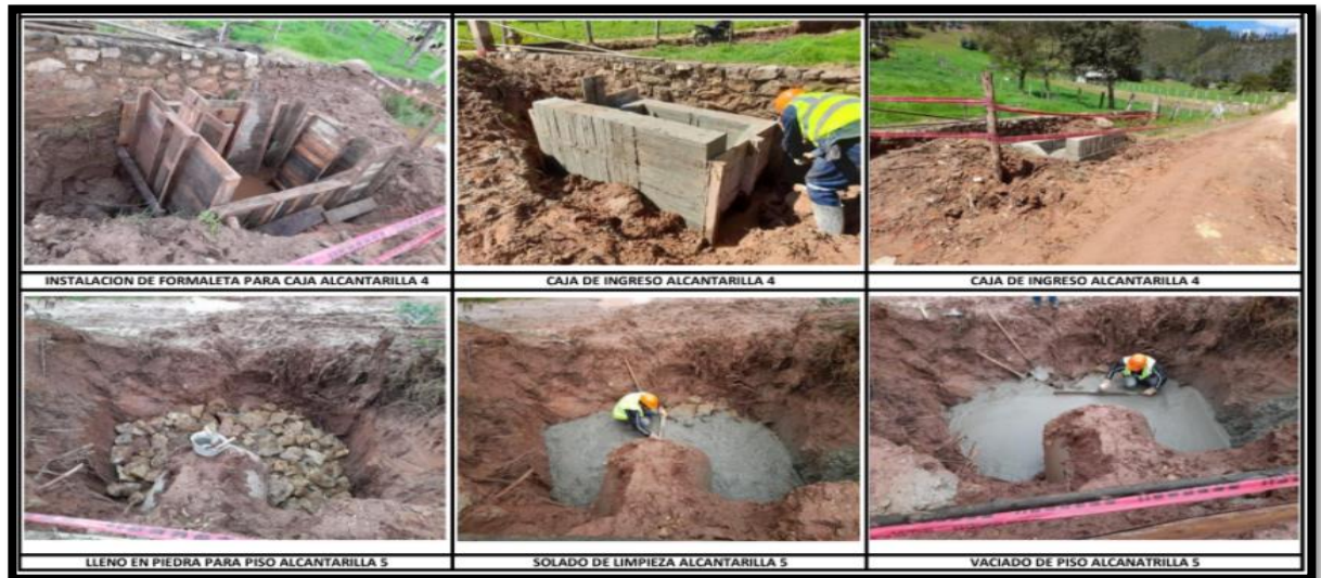
Figura 22. Mejoramiento del suelo y construcción de pisos.
