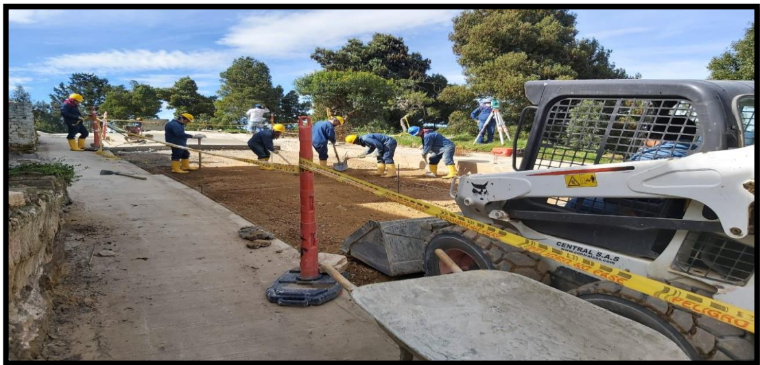
Figura 7. Compactación de la subbase.
