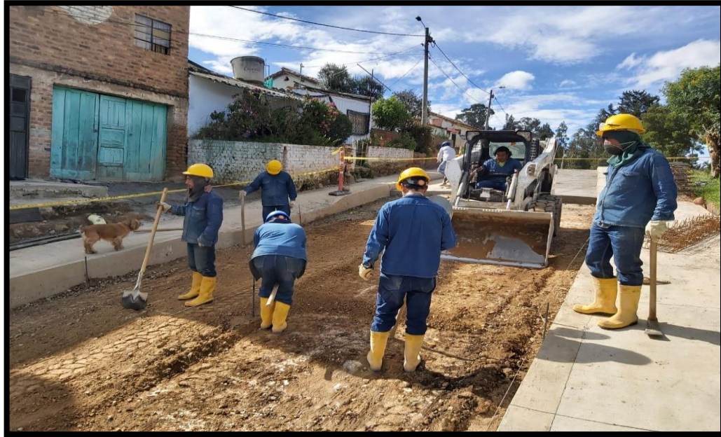
Figura 8. Limpieza de la subrasante.
