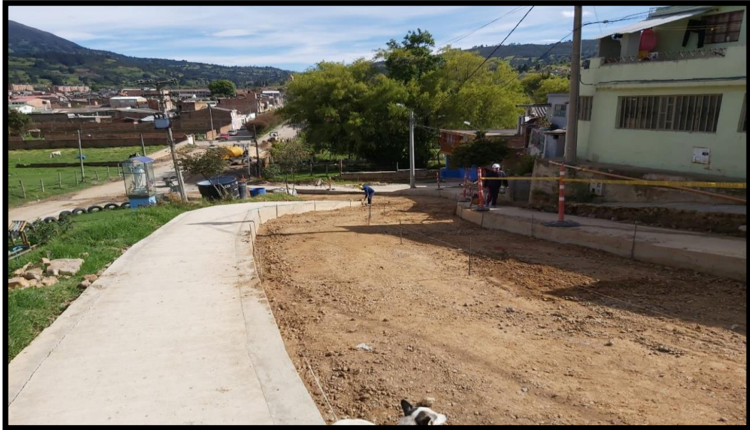
Figura 10. Instalación de formaletas según los ejes topográficos.
