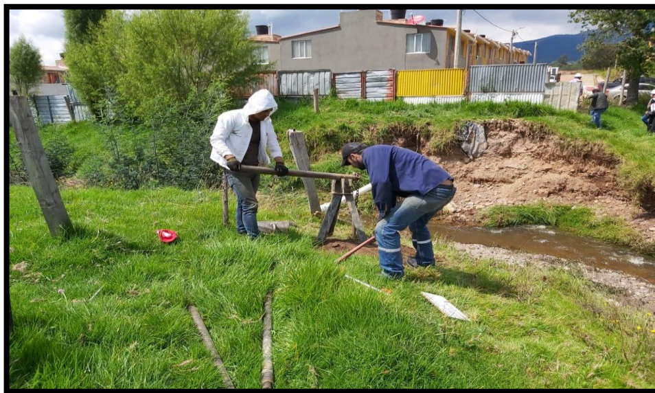
Figura 48. Evidencia fotográfica de apiques, para la muestra de suelo.
