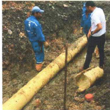
• Fotografía #4: Instalación del tubo de alcantarillado Novafort 12" en PVC en la transversal 8 salida a Miraflores.
